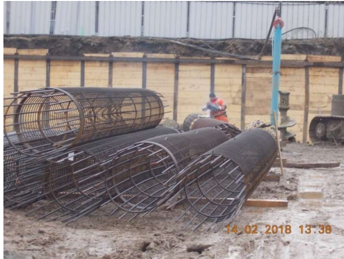
Figura 6.22. Armături pregătite pentru sudare
