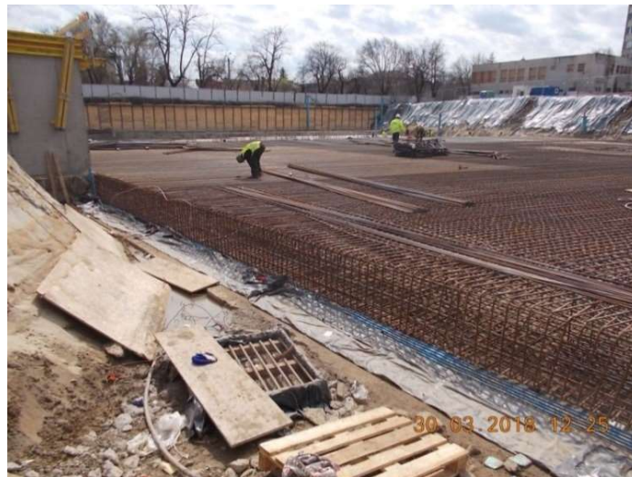
Figura 6.73. Grosimea radierului pe zona S+4E+Er
