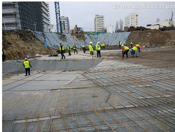
Figura 6.67. Montarea armăturii inferioare a radierului pe o direcție
