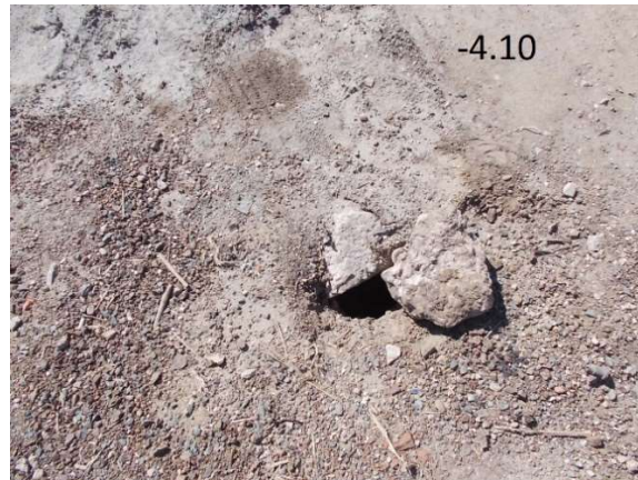
Figura 4.27. Nivel freatic interceptat la cota -4.10
