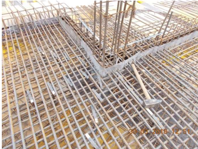
Figura 6.74. Rost de turnare
