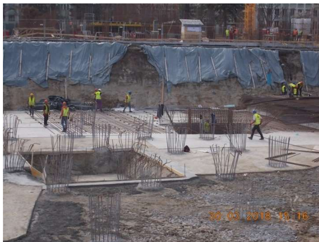
Figura 6.46. Începerea armării radierului
