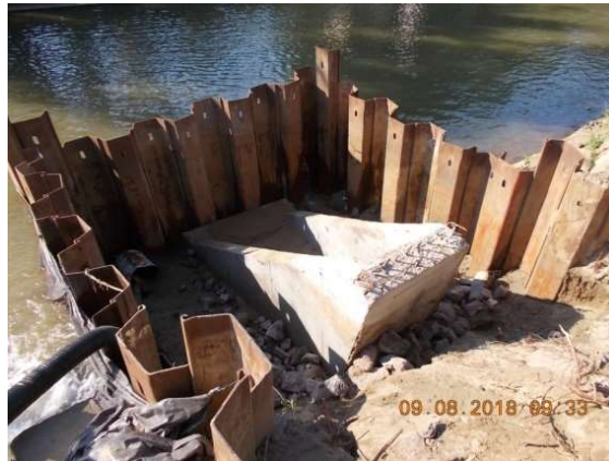
Figura 8.12. Betonare priză de captare
