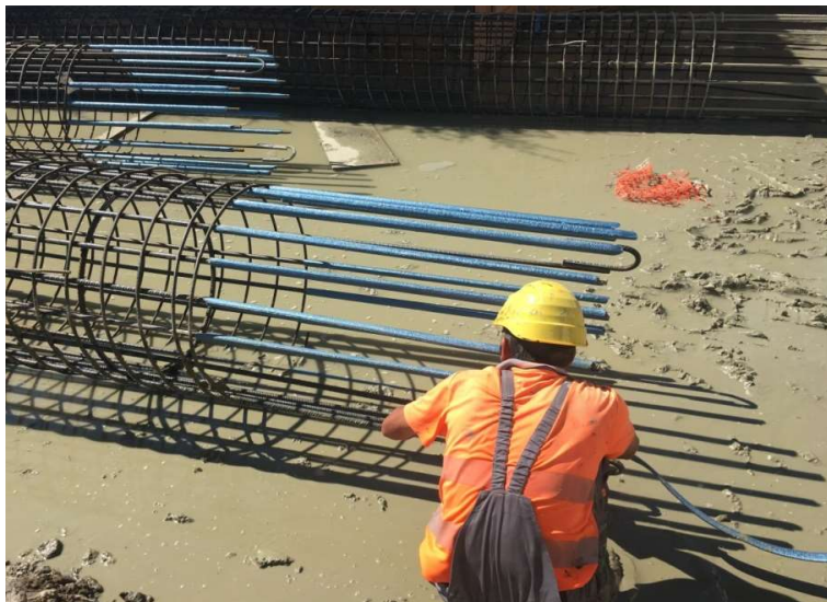
Figura 6.25. Introducerea Copex-ului pe armături pentru protejarea lor în momentul spargerii betonului contaminat
