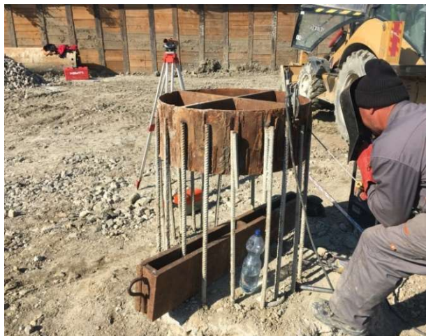
Figura 6.54. Sudarea virolelor pentru realizarea probelor
