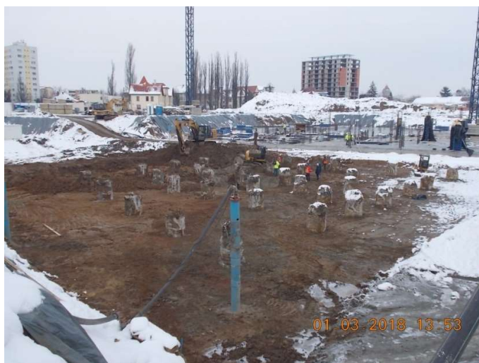
Figura 6.35. Pregătirea suprafeței din jurul piloților pentru turnarea betonului de egalizare
