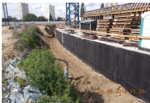
Figura 7.5. Realizare umpluturi perimetrice subsolului
