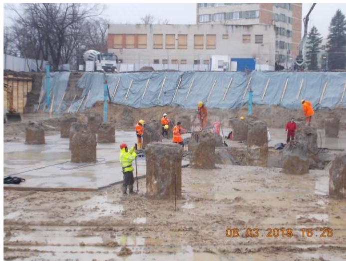
Figura 6.38. Spargerea betonului contaminat
