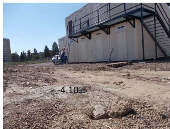
Figura 4.28. Nivel freatic interceptat la cota -4.10
