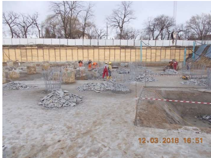
Figura 6.40. Spargerea betonului contaminat
