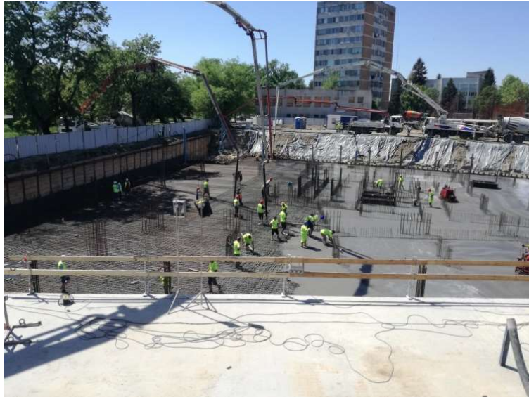
Figura 6.86. Turnarea radierului
