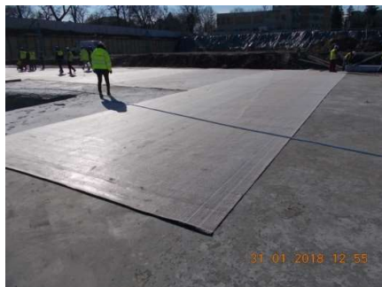
Figura 7.12. Hidroizolație radier
