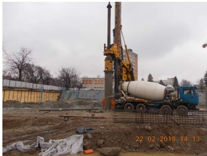
Figura 6.21. Finalizarea forării piloților
