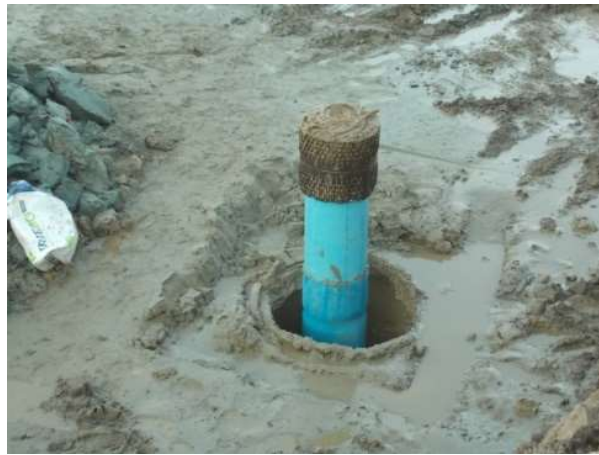
Figura 4.32. Introducerea tubulaturii din foraje
