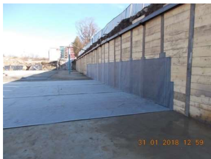
Figura 7.10. Hidroizolație montată pe berlineză
