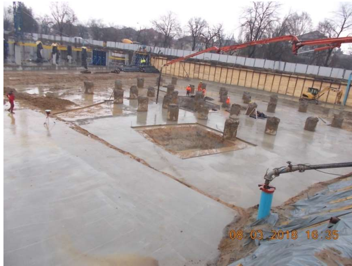
Figura 6.36. Turnarea betonului de egalizare
