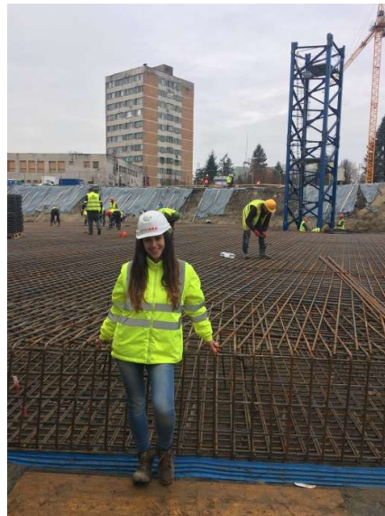
Figura 6.79. Realizare verificări armatură
