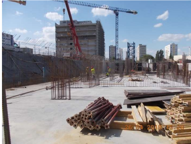
Figura 6.90. Placa turnată cu mustățile lăsate pentru elementele verticale de la subsol
