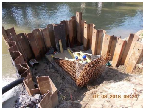
Figura 8.11. Armare priză de captare
