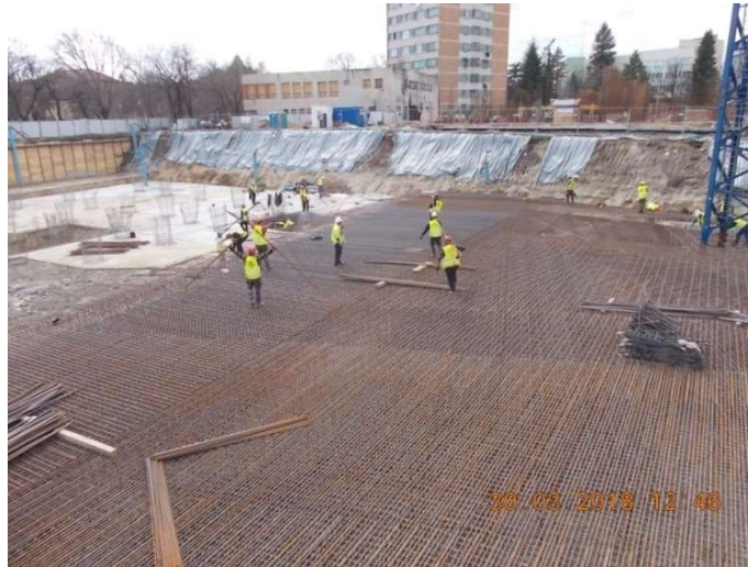
Figura 6.72. Finalizarea armăturii primului plot de radier
