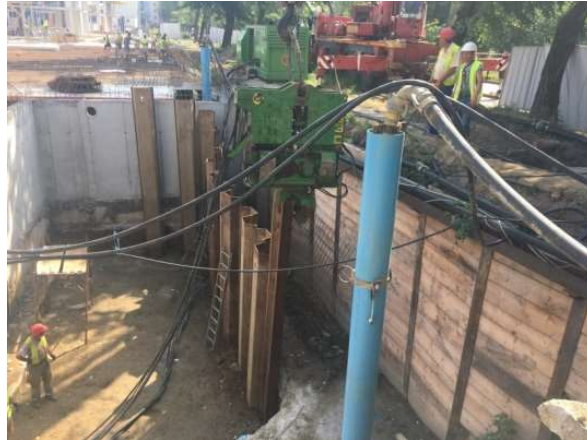
Figura 8.14. Batere palplanșe pentru stația de pompare
