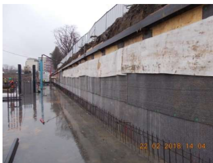
Figura 7.11. Finalizare montaj hidroizolație berlineză
