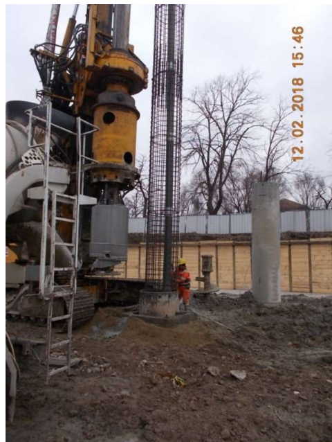
Figura 6.27. Introducerea carcaselor de armătură în foraj
