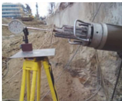
Figura 6.103. Tensionare
