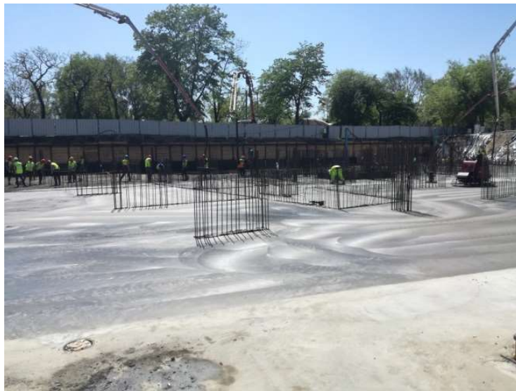
Figura 6.87. Turnarea și elicopterizarea radierului
