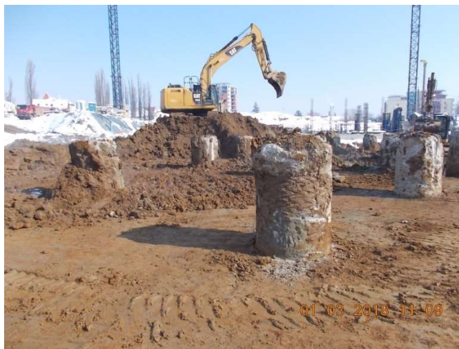
Figura 6.34. Pregătirea suprafeței din jurul piloților pentru turnarea betonului de egalizare
