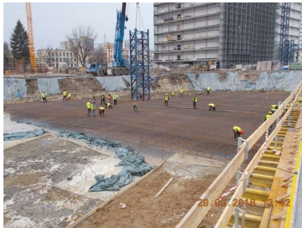
Figura 6.69. Legarea barelor independente de armătură pentru plasa superioară
