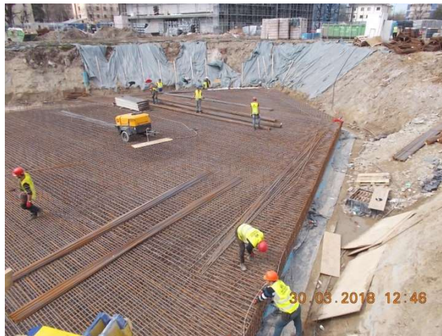
Figura 6.71. Legarea barelor independente de armătură pentru plasa superioară
