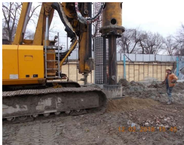
Figura 6.26. Pregătirea introducerii carcaselor de armătură în foraj
