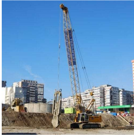
Figura 6.3. Utilaj folosit pentru execuția pereților mulați
