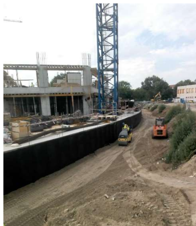
Figura 7.6. Compactare umpluturi lângă hidroizolație
