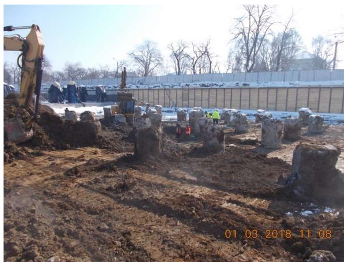
Figura 6.33. Pregătirea suprafeței din jurul piloților pentru turnarea betonului de egalizare
