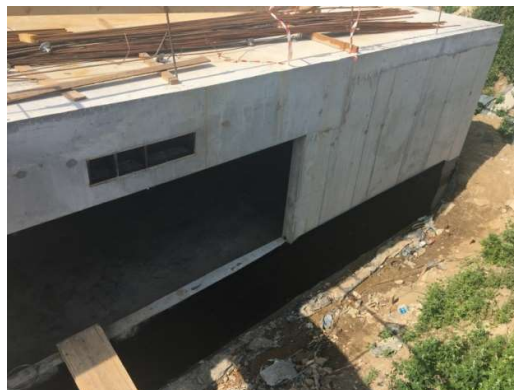
Figura 7.2. Hidroizolație temporară
