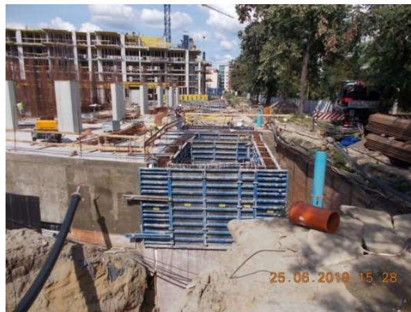
Figura 8.15. Cofrare stație de pompe
