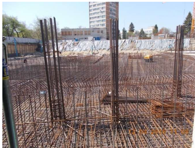
Figura 6.83. Montarea elementelor verticale care ies din radier
