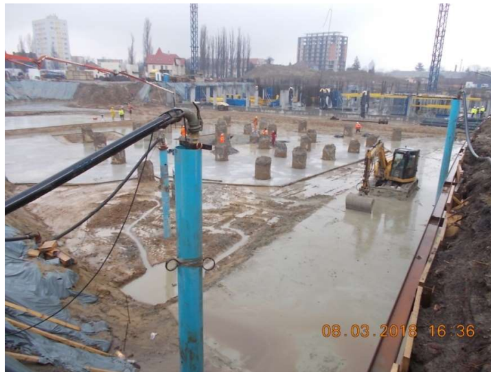
Figura 6.37. Turnarea betonului de egalizare
