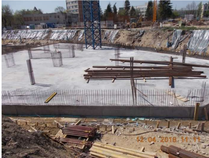
Figura 6.88. Placa turnată cu mustățile lăsate pentru elementele verticale de la subsol
