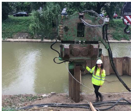
Figura 8.9. Batare palplanșe pentru priza de captare
