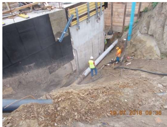
Figura 8.13. Subtraversare priză de captare – stație de pompare
