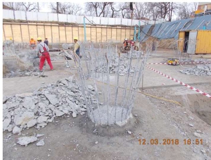
Figura 6.41. Armătură rămasă după spargerea betonului contaminat
