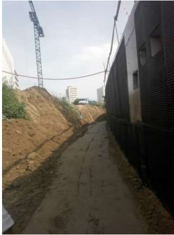
Figura 7.7. Pământul compactat de lângă subsol
