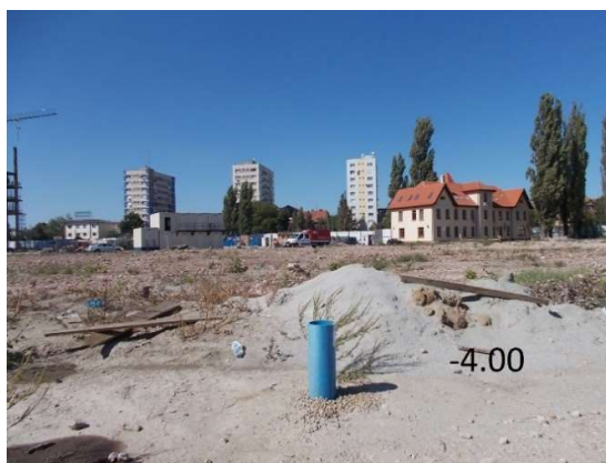
Figura 4.26. Nivel freatic interceptat la cota -4.00
