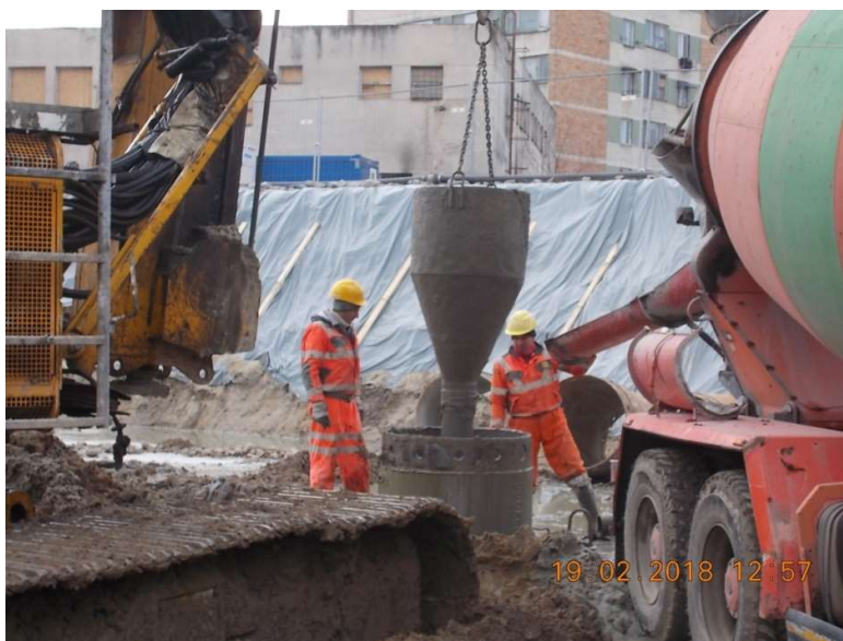
Figura 6.31. Turnarea betonului în piloți
