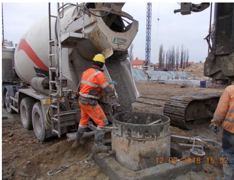
Figura 6.30. Turnarea betonului în piloți
