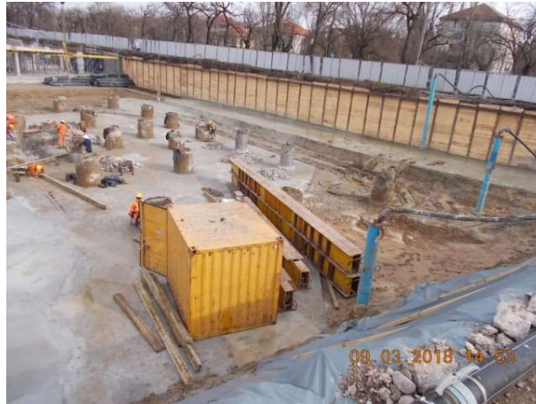
Figura 6.53. Aducerea în șantier a probelor pentru realizarea testelor
