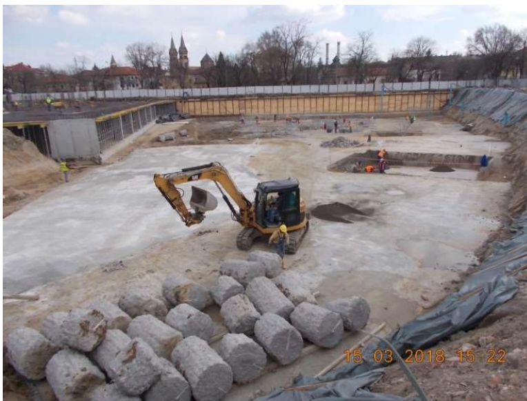
Figura 6.42. Înlăturarea betonul spart de la capetele piloților
