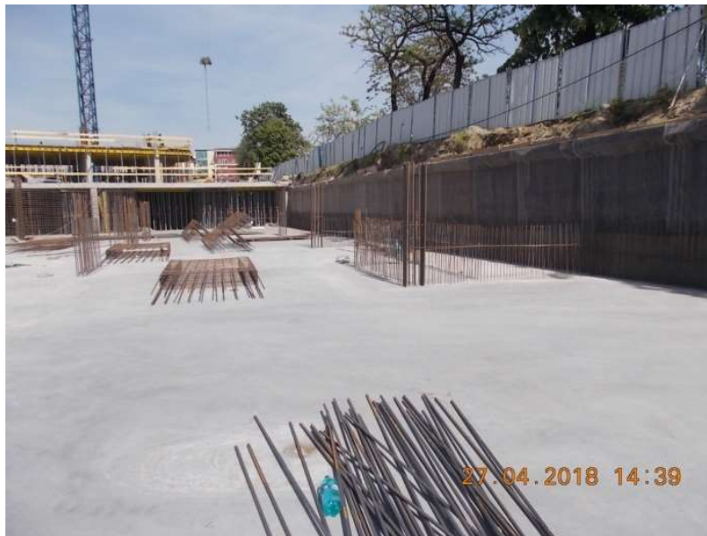
Figura 6.89. Placa turnată cu mustățile lăsate pentru elementele verticale de la subsol
