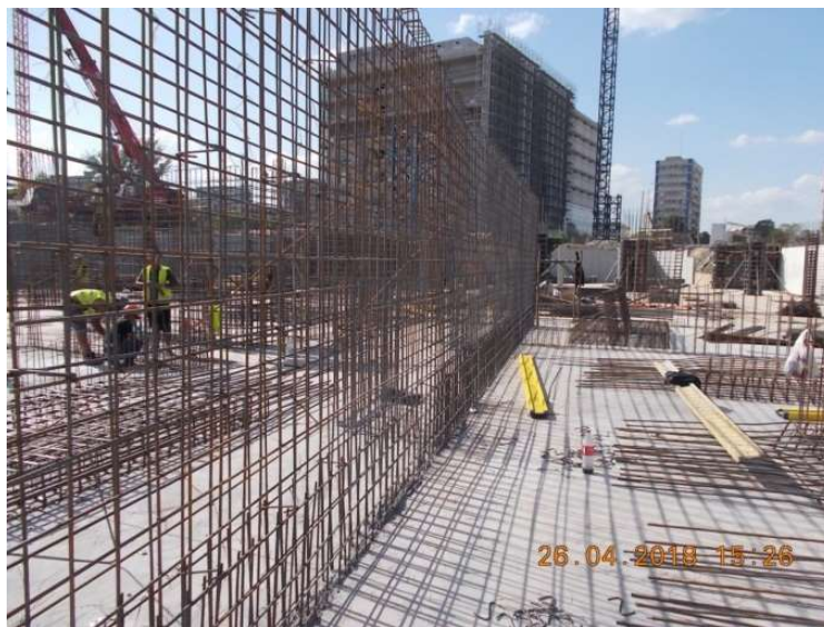
Figura 6.93. Elementele verticale de la subsol
