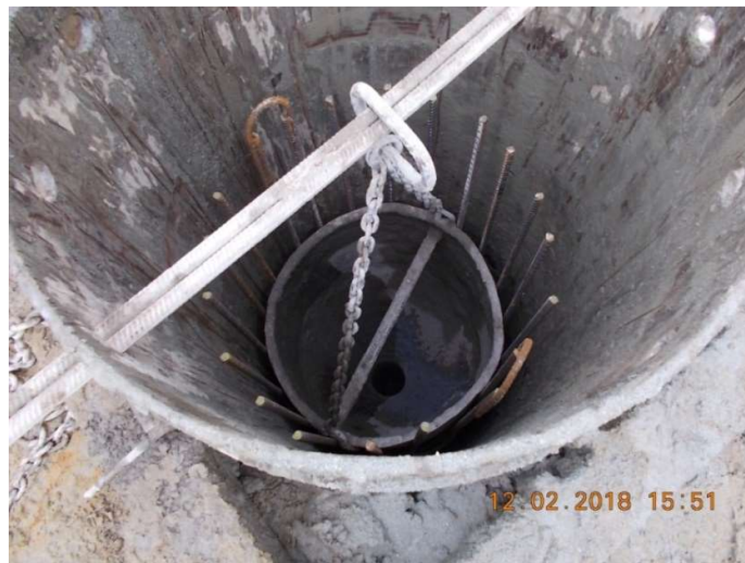
Figura 6.29. Pregătirea turnării betonului în piloți
