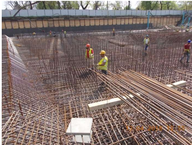
Figura 6.75. Armarea plotului 2 de radier
