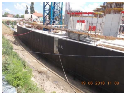
Figura 7.4. Montaj membrana Armodillo
