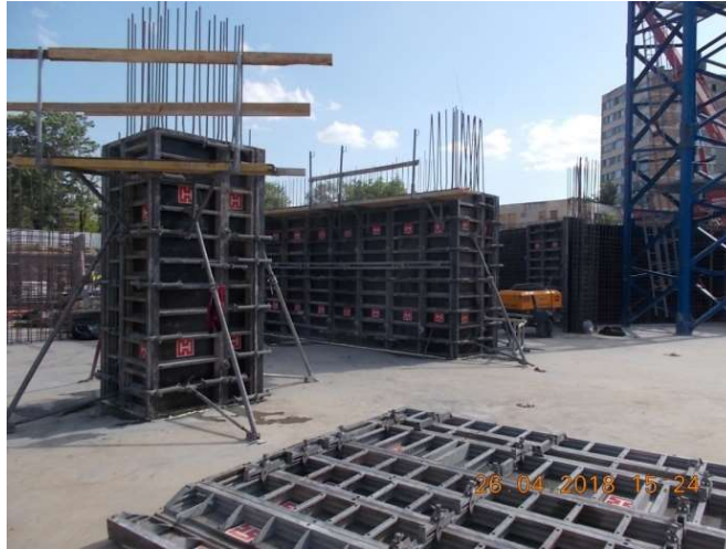
Figura 6.94. Cofrare și turnare elemente verticale de la subsol și continuarea lucrărilor pe verticală
