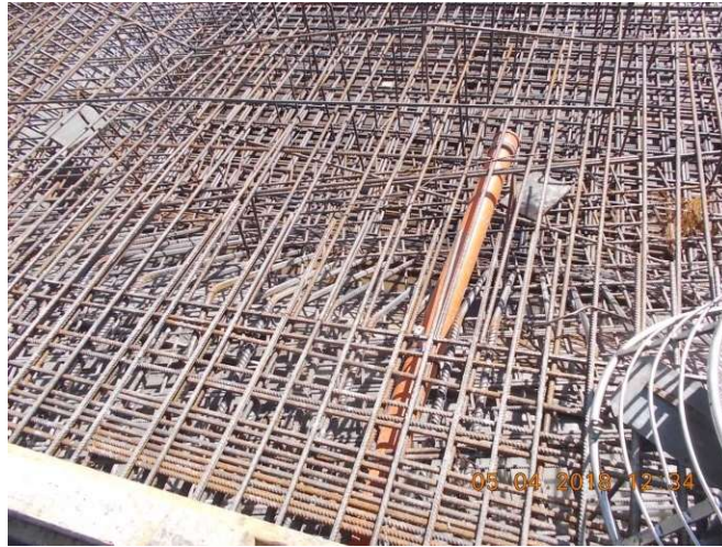
Figura 6.80. Montarea instalațiilor în radier
