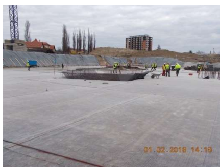
Figura 7.13. Hidroizolația aplicată pe întreaga suprafață a radierului
