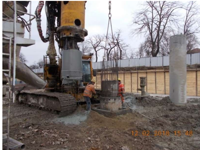
Figura 6.28. Carcasa de armătură introdusă în foraj
