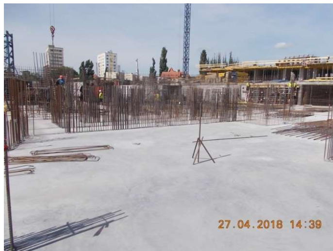
Figura 6.91. Montarea elementelor verticale de la subsol prin legarea carcaselor de armătură de mustățile lăsate din placă
