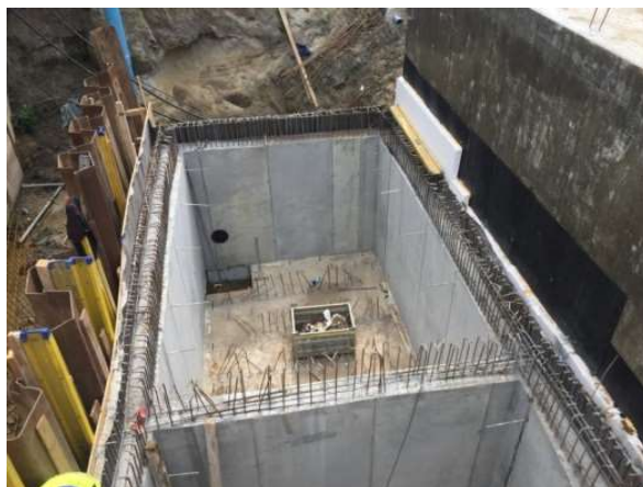
Figura 8.16. Armare+betonare stație de pompe
