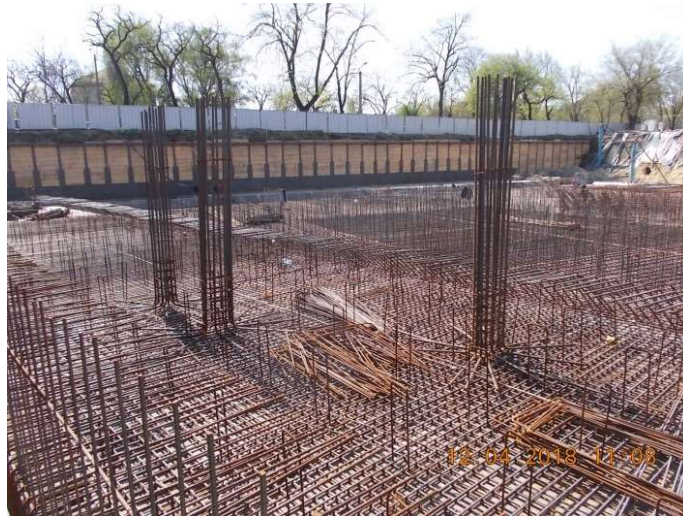
Figura 6.82. Montarea elementelor verticale care ies din radier
