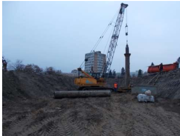
Figura 4.31. Realizarea forajelor
