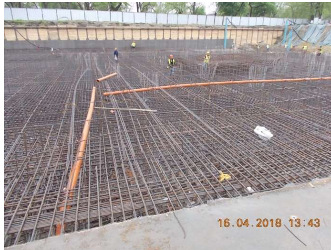
Figura 6.81. Montarea instalațiilor în radier
