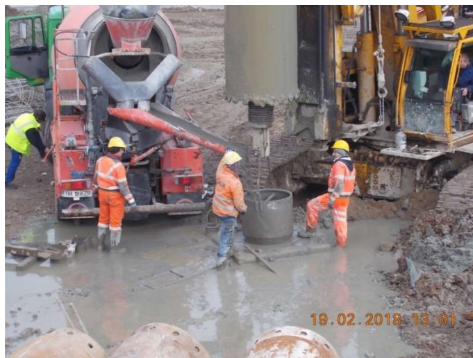
Figura 6.32. Turnarea betonului în piloți
