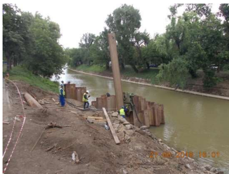
Figura 8.10. Batare palplanșe pentru priza de captare
