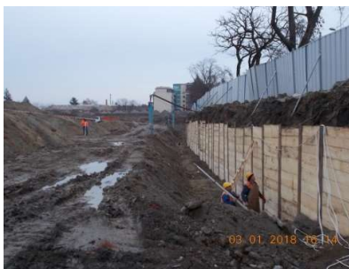
Figura 5.5. Sprijinire mal cu ajutorul berlinezei
