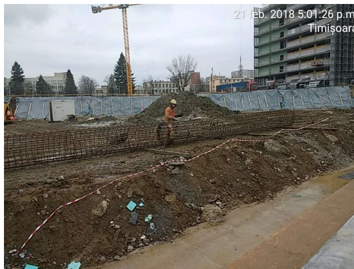
Figura 6.23. Îmbinarea carcaselor de armătură
