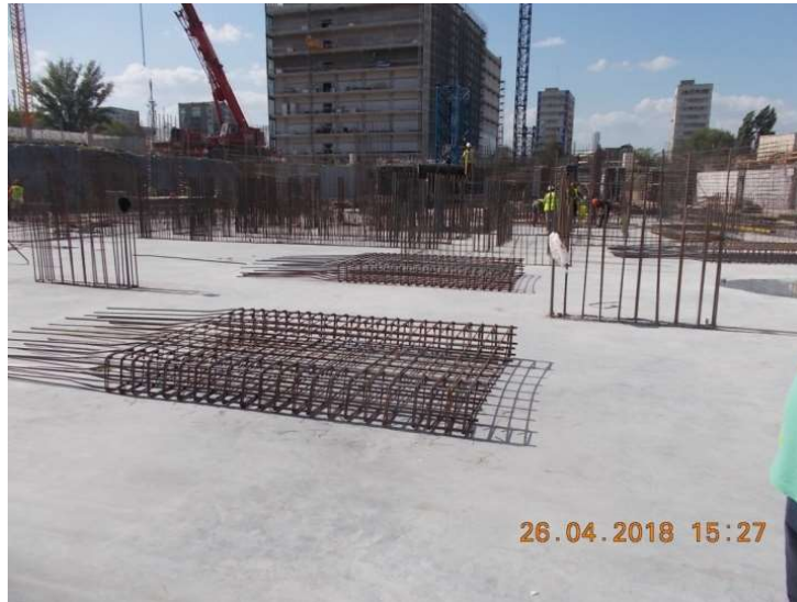
Figura 6.92. Montarea elementelor verticale de la subsol prin legarea carcaselor de armătură de mustățile lăsate din placă
