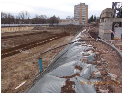
Figura 5.6. Realizare taluz cu panta 1:1, protejat cu folie
