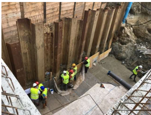
Figura 7.14. Aplicare hidroizolație radier casa pompelor
