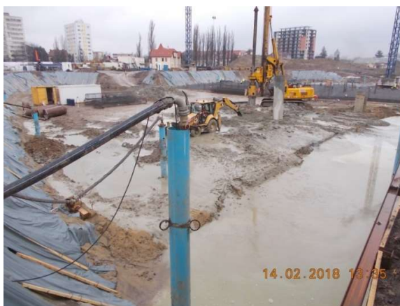
Figura 6.18. Începerea lucrărilor de forare a piloților
