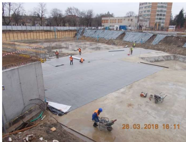
Figura 6.66. Aplicare hidroizolație Voltex
