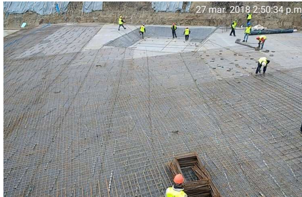
Figura 6.68. Montarea armaturii inferioare a radierului și pe cea de-a doua direcție
