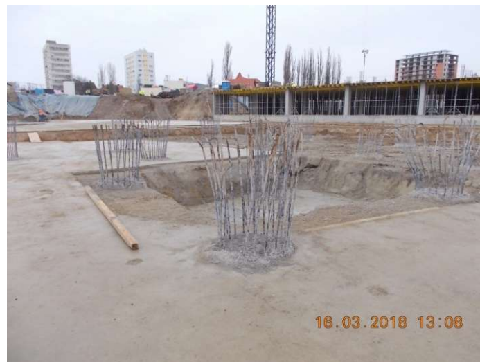
Figura 6.45. Mustățile de armătură rămase după spargerea betonului contaminat al piloților
