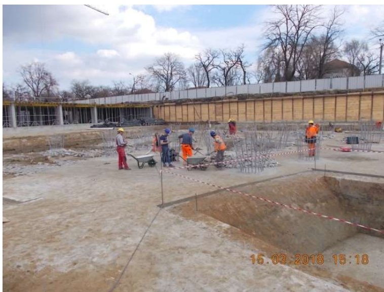
Figura 6.43. Înlăturarea betonul spart de la capetele piloților
