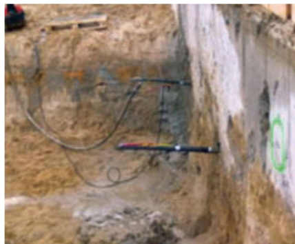
Figura 6.102. Introducere ancoră și injectare
