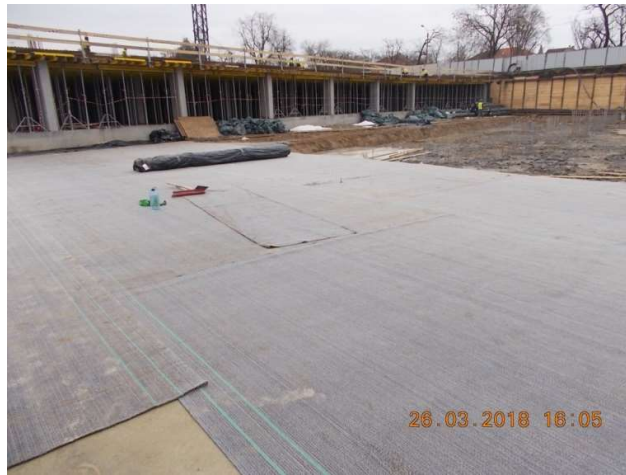
Figura 6.65. Aplicare hidroizolație Voltex
