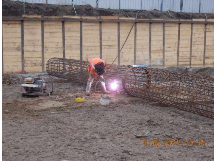
Figura 6.24. Sudarea carcaselor de armătură
