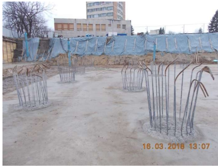
Figura 6.44. Mustățile de armătură rămase după spargerea betonului contaminat al piloților
