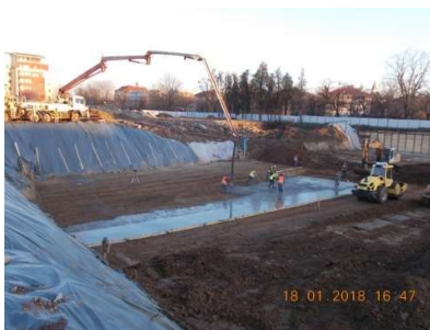
Figura 5.7. Turnarea betonului de egalizare după finalizarea protejării malurilor
