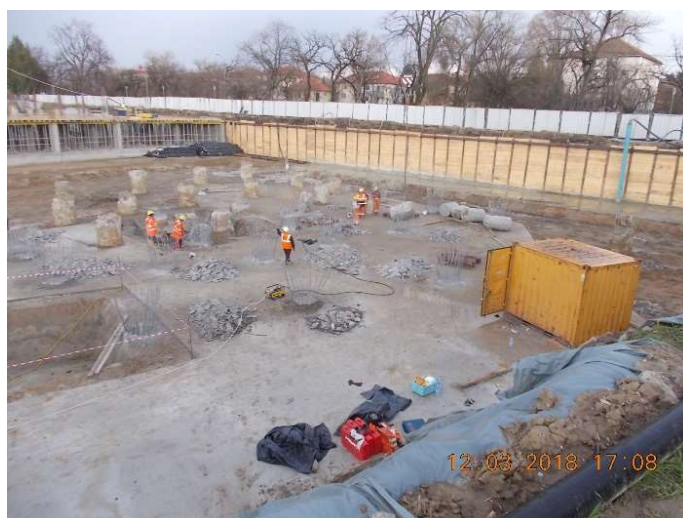
Figura 6.39. Spargerea betonului contaminat
