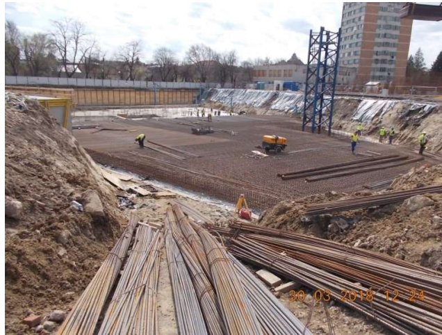
Figura 6.70. Legarea barelor independente de armătură pentru plasa superioară
