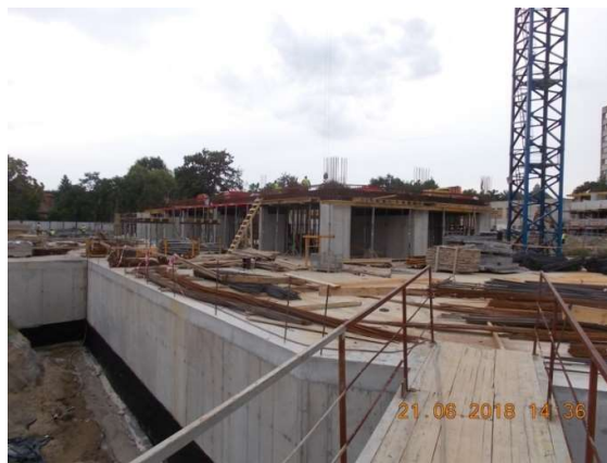
Figura 174. Hidroizolație temporară
