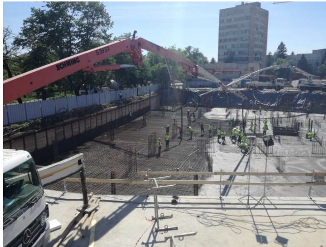
Figura 6.85. Turnarea radierului + pompa calată
