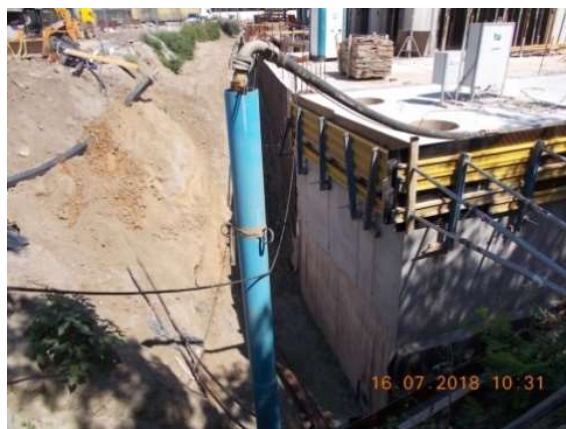
Figura 4.34. Pomparea apei din epuziment
