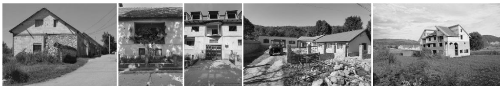
Fig. 2.35 Intervenții neadecvate în mediul construit rural: 1 – redesenarea volumului casei prin utilizarea unor materiale moderne, fără relații și atitudini concrete vizavi de existent (Potoc); 2 – tratarea diferită a fațadei față de specificul local, dimensiunea și proporția gurilor (zona Cornereva); 3 – ascalarul, decorația, nonsensul (zona Cornereva); 4 – dispunerea diferită a construcției pe teren și mobilarea excesivă a acestuia (Ciclova Română); 5 – construcția de tip nou în peisaj; sursa: 1,2,3,4 – fotografii proprii, 5 - ghid de arhitectură Caraș Severin, OAR
