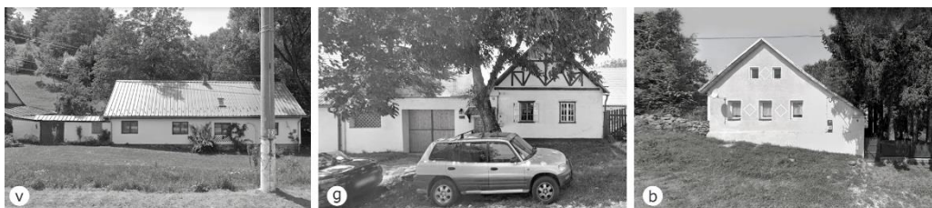
Fig. 6.38 Fațade ale caselor analizate în planimetrie: v - Văliug, casa R.R (exemplul nr.4), g - Gărâna, casa H.C., exemplul 3, b - Brebu Nou, casa M.C și N.C., exemplul 2, sursa: Google Maps, fotografiile personale
