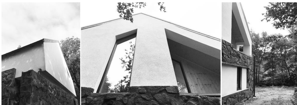
Fig. 6.47 Volumul exterior – suprapunerea pe registre prin materialități diferite, ale locului – parterul masiv din piatră zidită adusă din cariera învecinată și etajul tencuit alb
