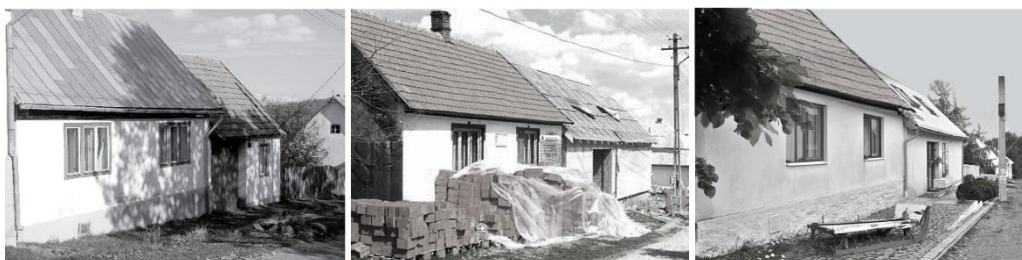
Fig. 6.36 Tranziție: din casă în pensiune (Sus in sat, Gărâna); stânga – casa veche, 2002, mijloc – pensiunea în șantier, 2007, dreapta – pensiunea finalizată (2020), sursa: Paul Buchert, Google Maps
