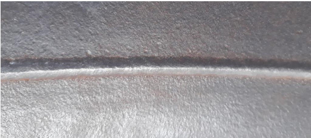
Fig.2.26. Profilul interior (rădăcină) al conductei sudate
