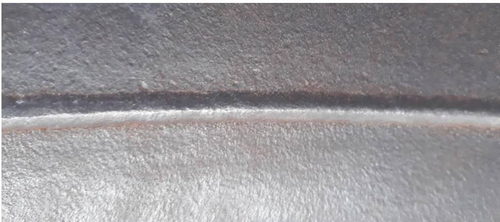
Fig.2.26. Profilul interior (rădăcină) al conductei sudate
