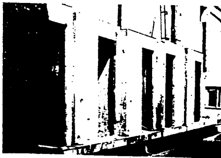
Fig.6.25. Cabine spațiale pentru băi din BG 300.
