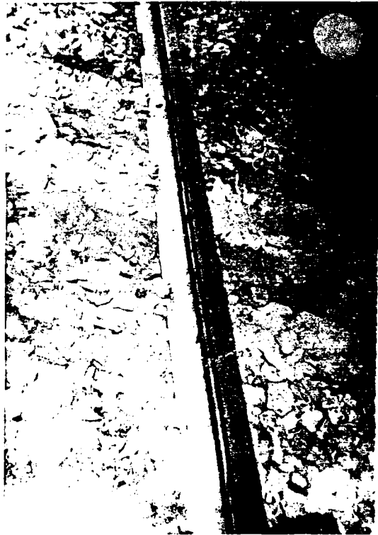
Fig. 3.5. Imagine de innoroire a oăii pe liniile cu prisma oăii cu exoes de piatră spartă (linia I Ploiești-Brașov, km. 63+978).
