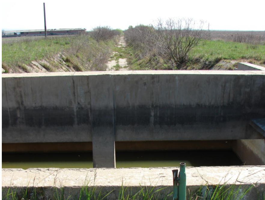
Foto 2.10 Bazin de refulare SP Plutitoare și canalul de Aducțiune I (foto Gabor A. – 2011)
