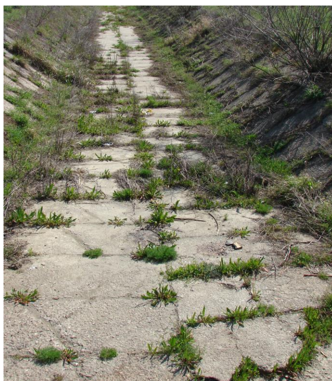
Foto 2.11 Canal de Aducțiune I (foto Gabor A. – 2011)
