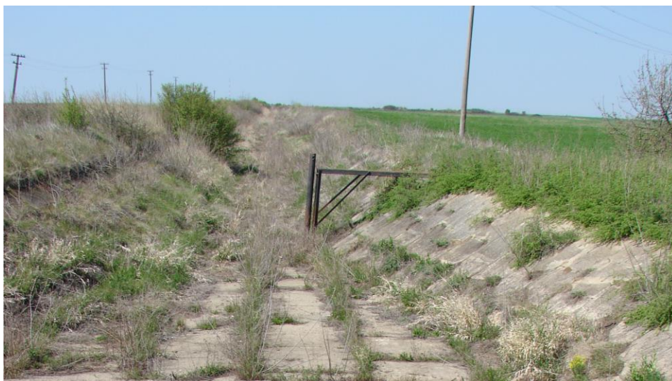
Foto 2.15 Canalul de Aducțiune II (foto Gabor A. – 2011)
