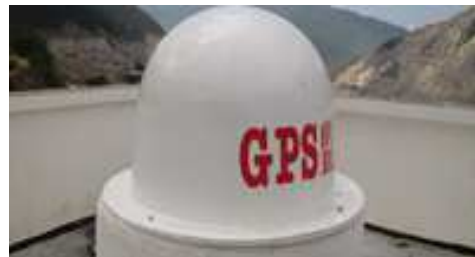
Fig. 2.8. Stație de monitorizare GPS situată pe un baraj
