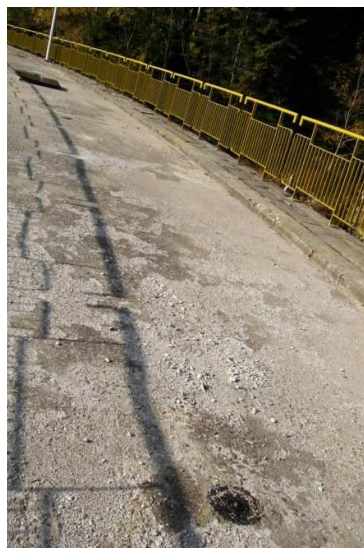
Fig. 6.20. Reperi de nivelment pe coronamentul barajului Petrimanu
