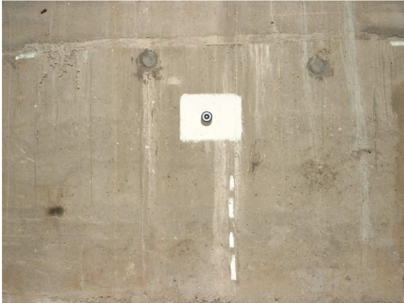
Fig. 6.15. Reper de microtriangulație pe paramentul barajului Petrimanu
