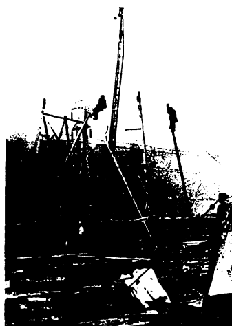
fig.1.7 Stîlp montat bară cu bară Romelectro Iran
