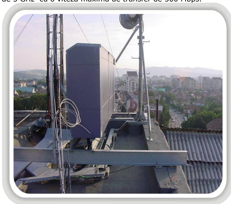
Figura 5.2. Stație de bază de test cu antene și emițătoare de microunde site central.
