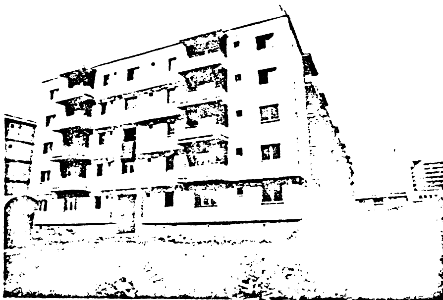
Blocul 88, Zona spitalului Județean Timișoara (1982) realizat cu fundații total prefabricate pe teren îmbunătățit cu vibromaiul
