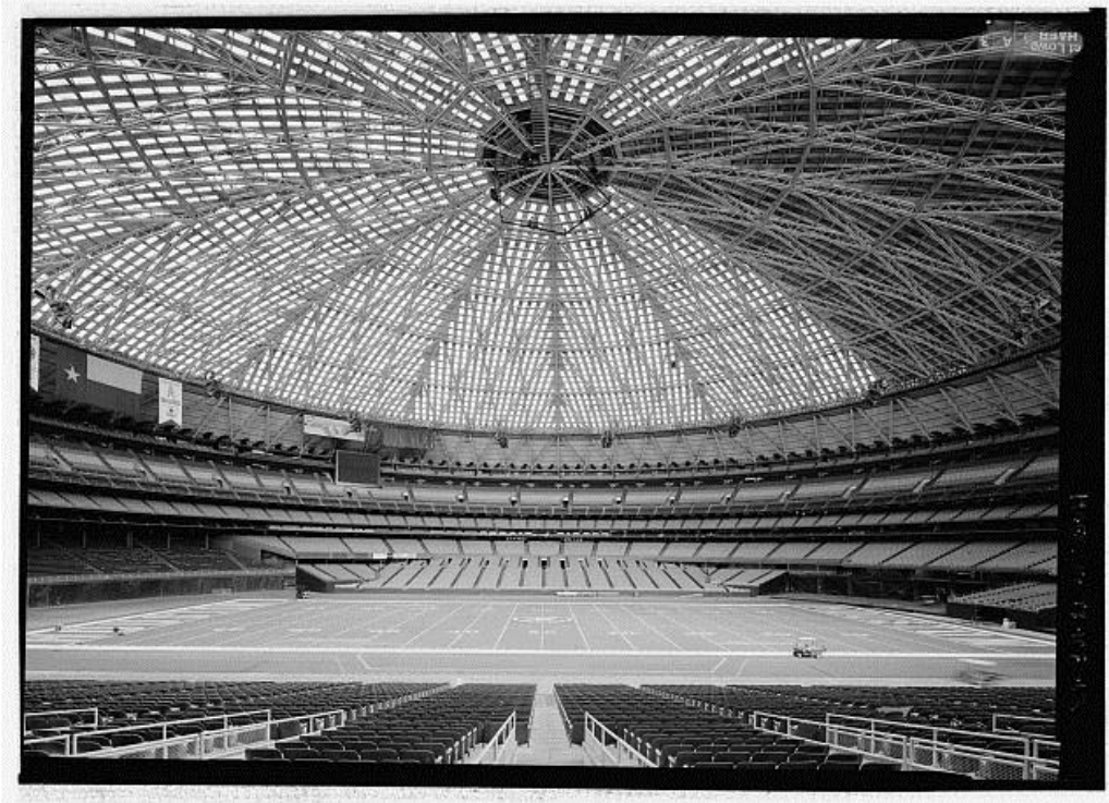
Fig. 1. 28. Cupola Astrodome peste stadionul din Houston, Texas - vedere interioară [15]
