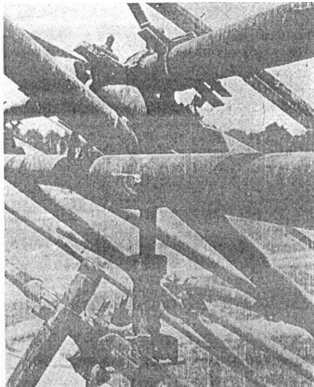
Fig. 2. 4. Îmbinarea nodurilor cu bride metalice [27]
