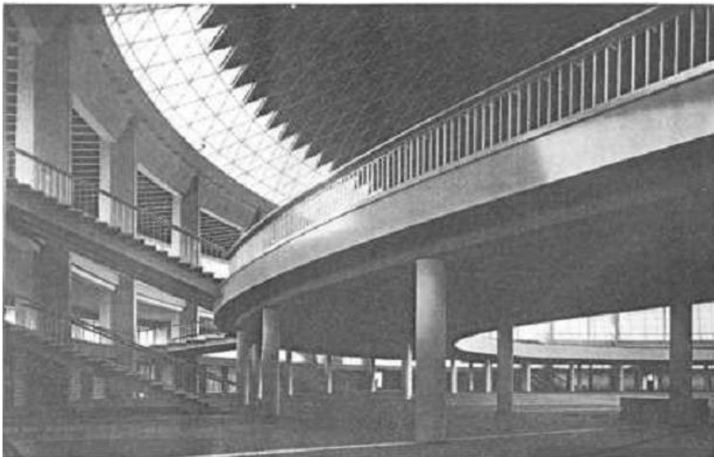
Fig. 2. 6. Imagini cu cupola reticulata simplu strat inainte de colaps [30]
