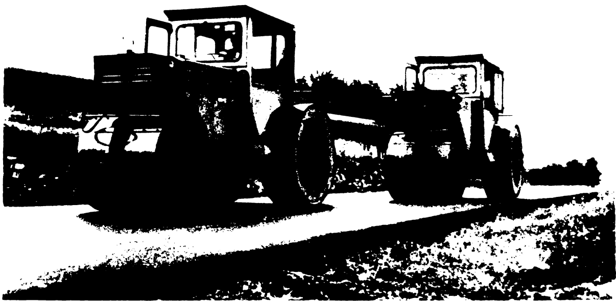
Fig.5.5.a Compactarea sectorului experimental
