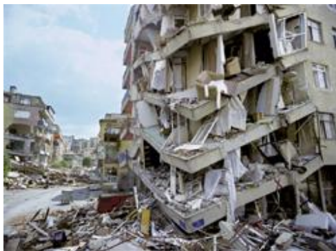
Fig.4.6. Prăbușirea unor clădiri în 1999, Turcia, datorită unui cutremur puternic
