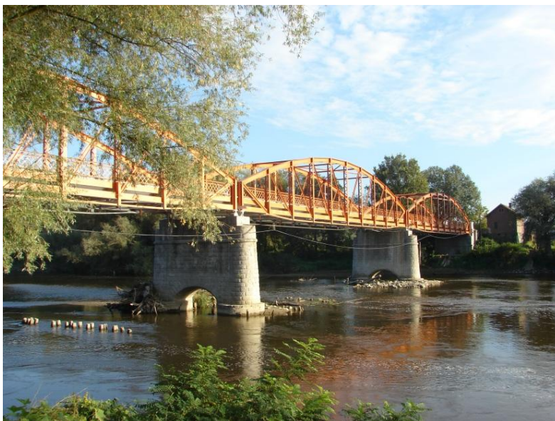
Fig.5.3 Vedere generală a podului după reabilitare
