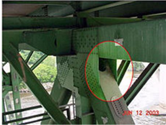
Fig.3.17. Gusee deformate (iunie 2003)
