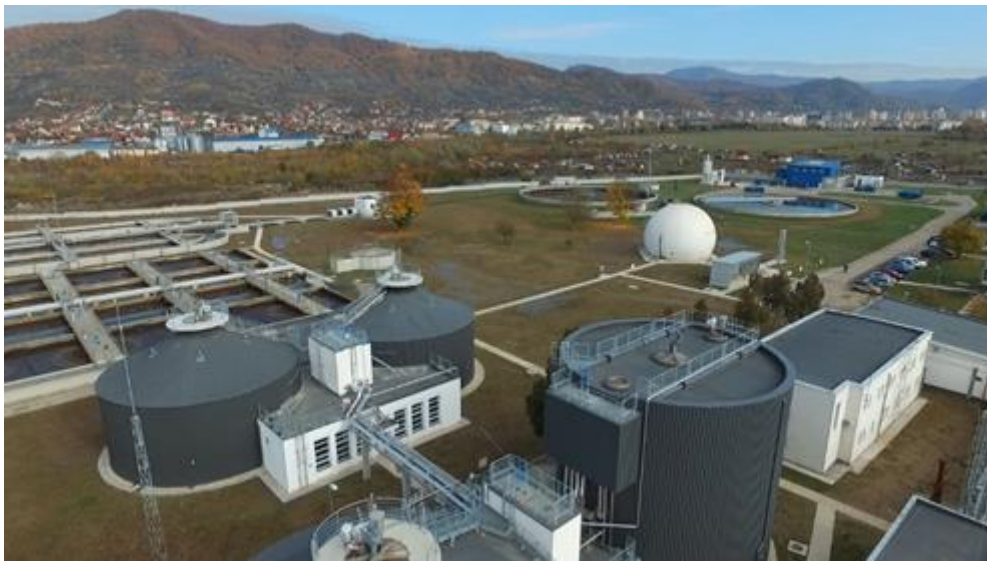
Fig.14. Stația de producere biogaz Baia Mare [69]
