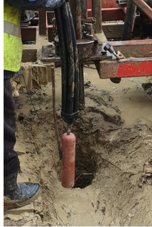
Fig. 5.4 Introducerea sondei geotermale în puțul forat împreună cu greutatea aferentă
