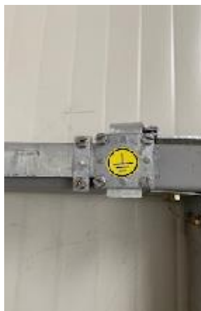
a. Eticheta de identificare a barei de echipotețializare
