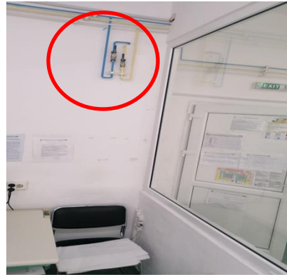
Fig. 0.15 Montare robinete oprire alimentare oxigen (imagini personale Neag N. P.)
