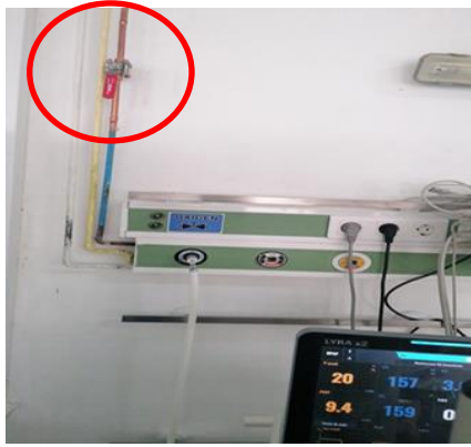
Fig. 0.15 Montare robinete oprire alimentare oxigen (imagini personale Neag N. P.)
