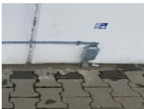
a. Conector la inelul de prize de pământ prevăzut cu placa de separație
