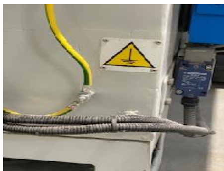
Fig. 0.12 Exemple de conectare carcasa echipamente la instalația de echipotețializare (rezultat de cercetare)
