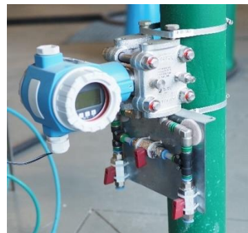
Figura 10. Manometru diferențial Deltabar S PMD75
