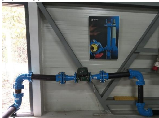
a) Debitmetru montat greșit
