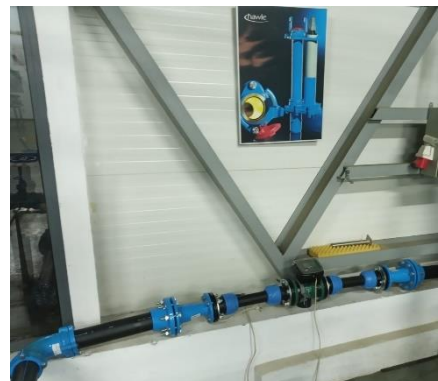
b) Debitmetru montat corect
