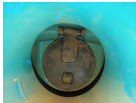
Figura 45. Clapetă de sens cu clapetă
