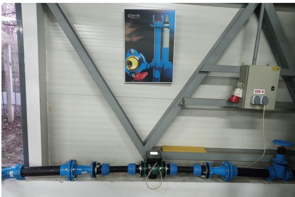
Figura 39. Debitmetrul electromagnetic montat pe un tronson cu diametru redus
