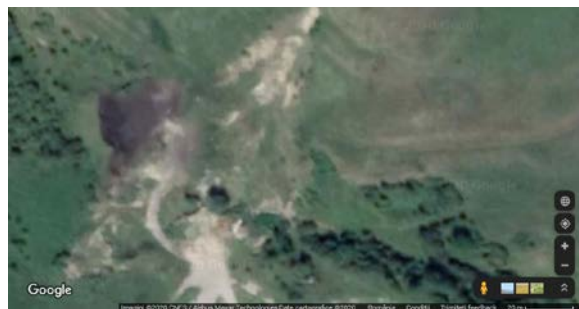
Figura 2.21. Depozitul de șlam aglomerare - furnale platforma industrială Sidermet Călan [26]
