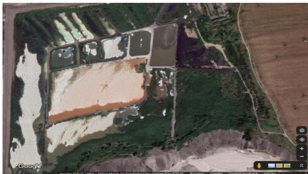
Figura 2.23. Iazul decantor a șlamului de furnal și convertizor rezultat pe platforma industrială a combinatului de la Galați [26].
