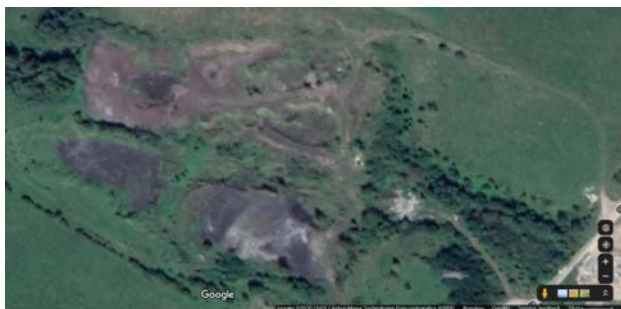
Figura 2.20. Depozitul de șlam aglomerare-furnale ArcelorMittal Hunedoara [26]
