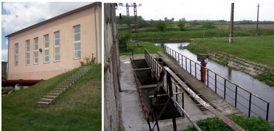
Figura 5.123. Stația de pompare Livezile I
