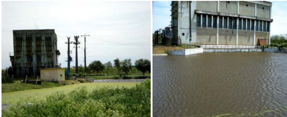
Figura 5.78. Stația de pompare Cenei II
