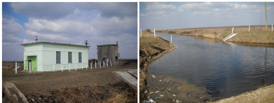
Figura 5.109 Stația de pompare Valcani II
