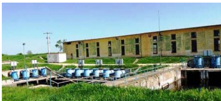
Figura 7.11.Stația de pompare Aranca
