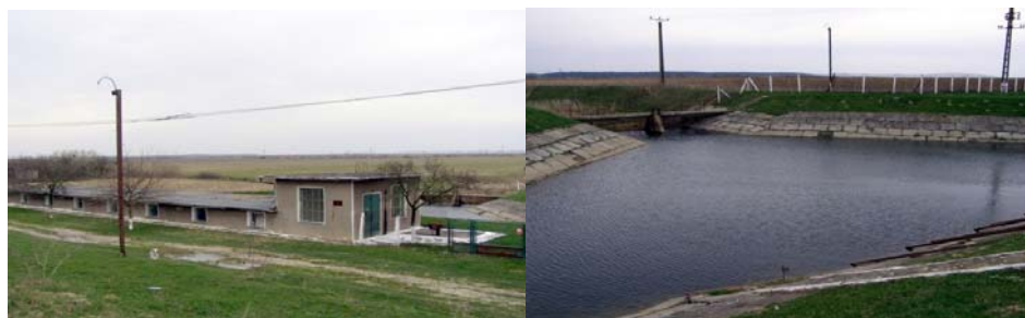
Figura 5.19. Stația de pompare Bazoș
