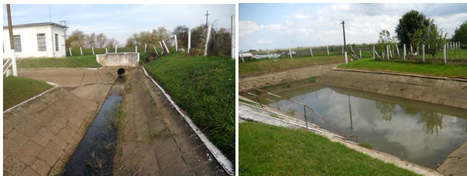
Figura 5.63. Stația de pompare Topolea
