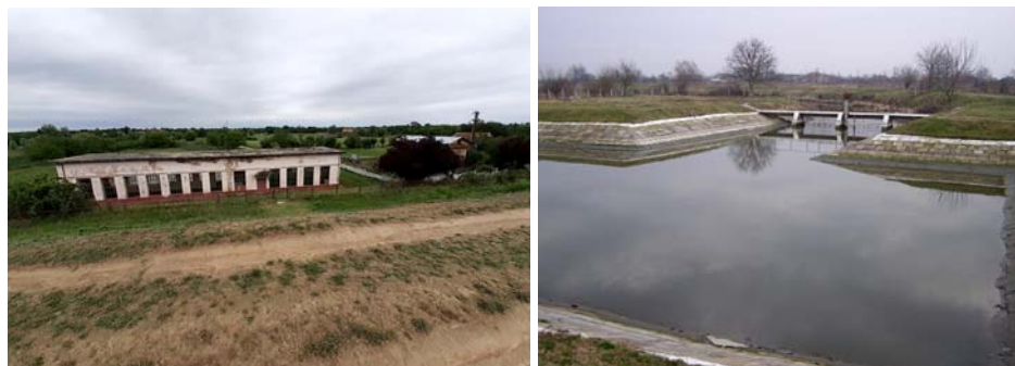
Figura 5.67. Stația de pompare Cebza
