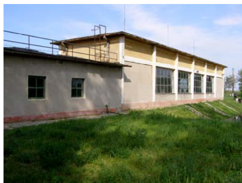
Figura 5.131. Stația de pompare Ghilad III amplificare
