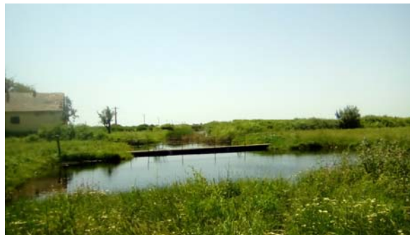
Figura 5.133. Stația de pompare Partoș I
