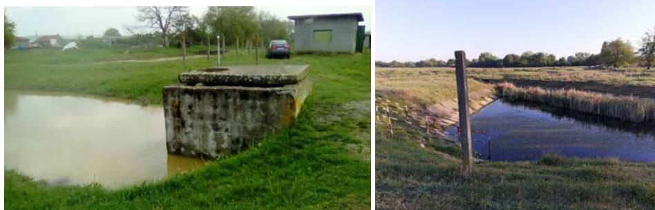
Figura 5.70. Stația de pompare Lugoj
