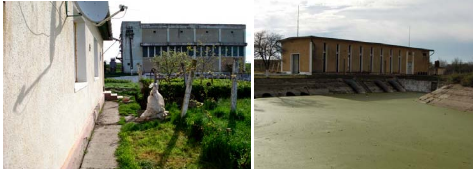
Figura 5.77. Stația de pompare Cenei I
