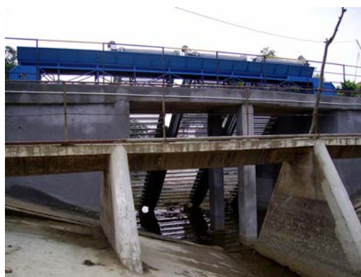
Figura 5.68. Stația de pompare Macedonia
