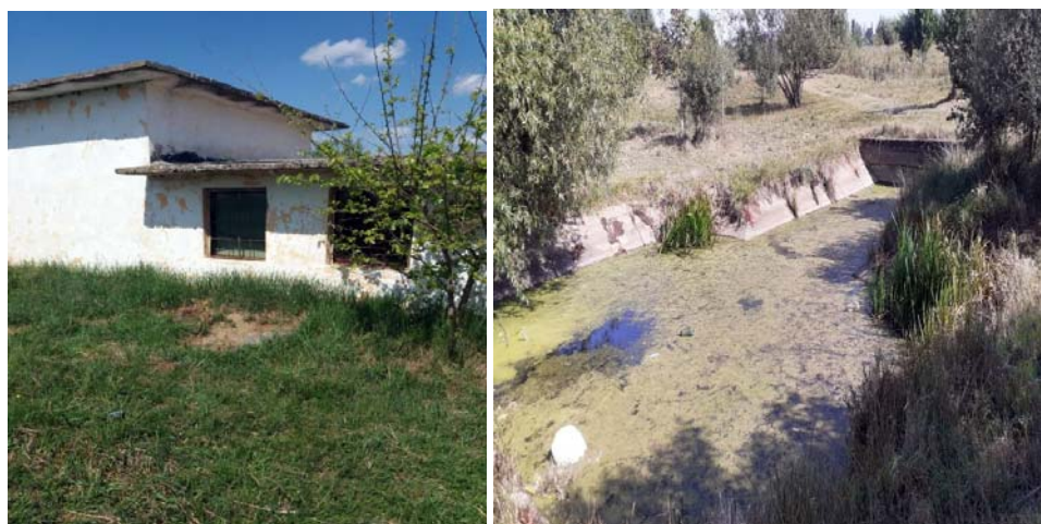
Figura 5.24. Stația de pompare Freidorf
