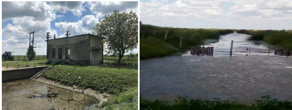
Figura 5.99. Stația de pompare Beregsău II
