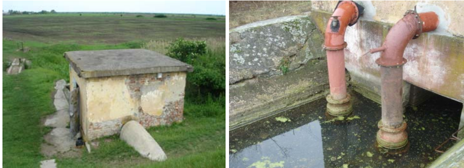
Figura 5.87. Stația de pompare Sânmartin mal drept
