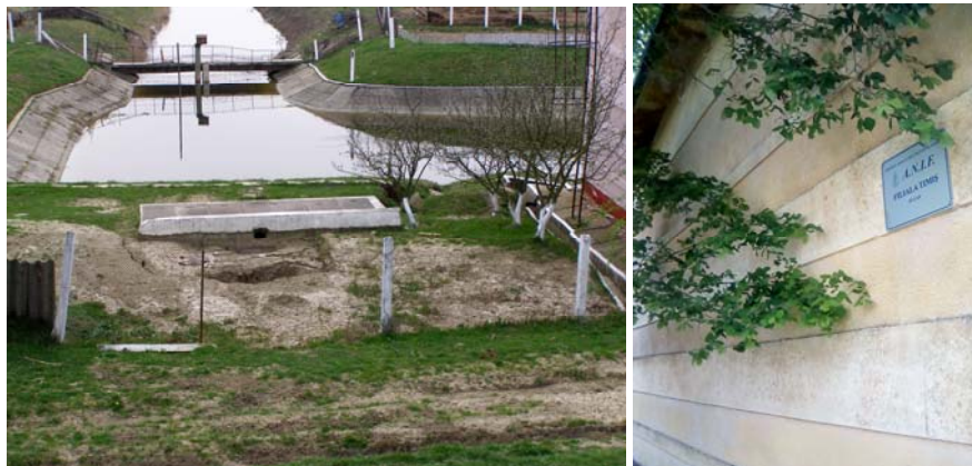
Figura 5.53. Stația de pompare Gad
