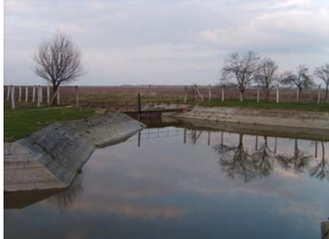
Figura 5.83. Stația de pompare Bobda I, bazin aspirație și bazin refulare
