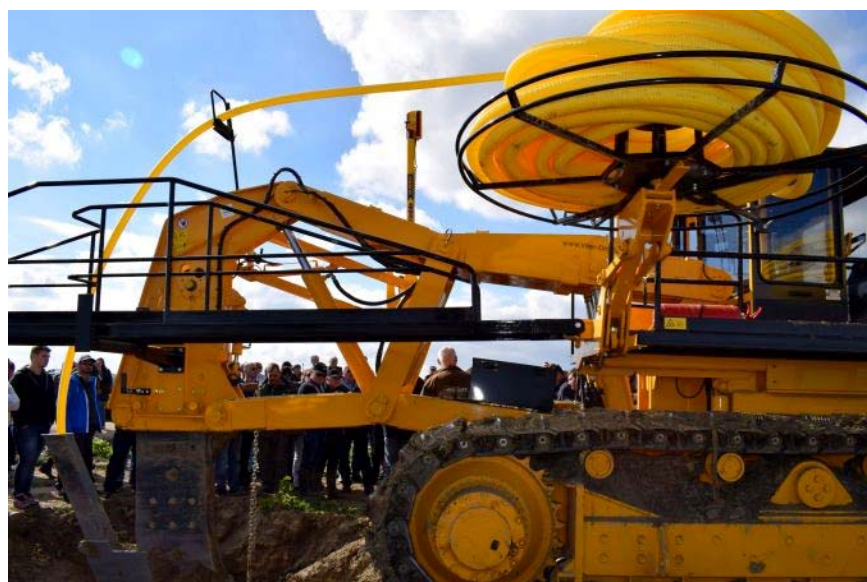
Figură 7.4. Mașină pentru executat drenuri (prezent) https://www.inter-drain.com/index.php/en/
