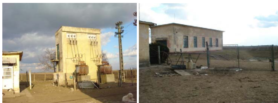
Figura 5.80. Stația de prepompare Grabați
