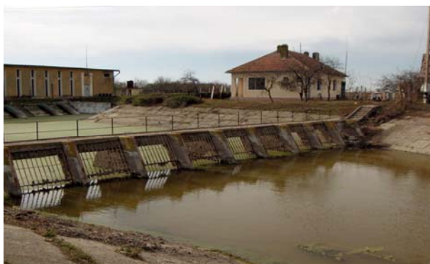
Figura 7.18. Stația de pompare Cenei
