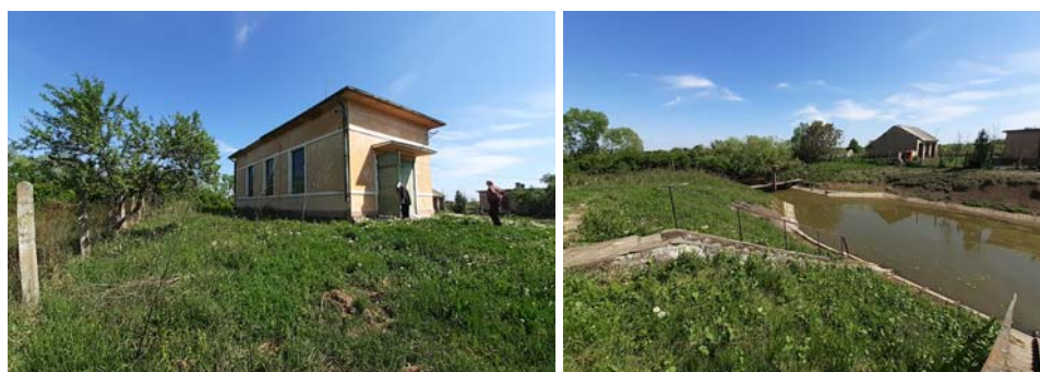
Figura 5.12. Stația de pompare Chizătău și bazinul de aspirație
