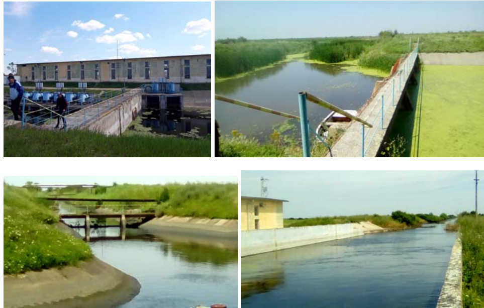
Figura 5.101. Stația de pompare Aranca
