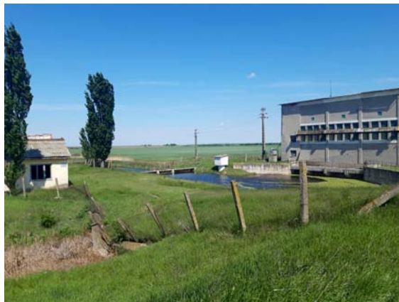
Figura 5.105. Stația de pompare Țiganca
