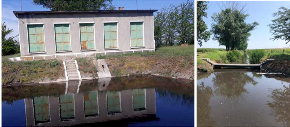
Figura 5.110. Stația de pompare Teremia
