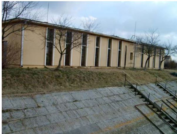
Figura 7.16. Stația de pompare Cenei
