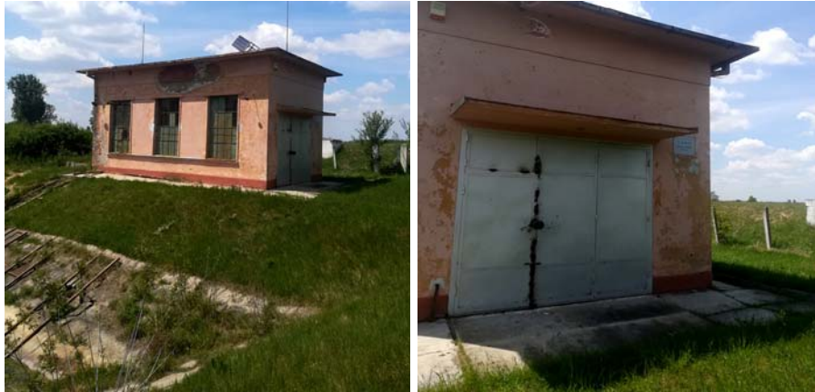
Figura 5.61. Stația de pompare Șurgani IV
