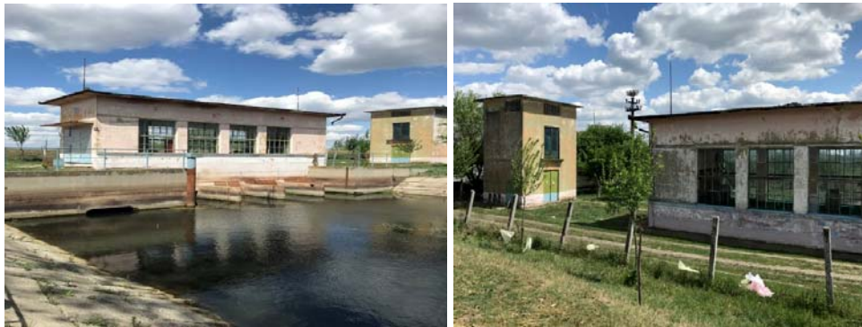
Figura 5.75. Stația de pompare Bobda II
