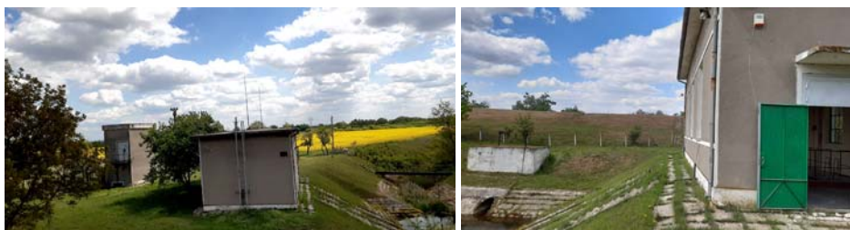
Figura 5.49. Stația de pompare Unip
