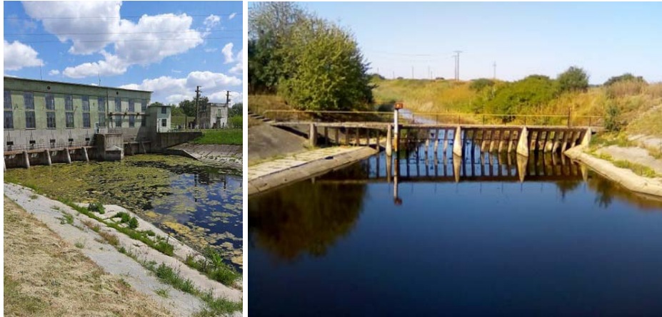
Figura 5.106. Stația de pompare Mureș
