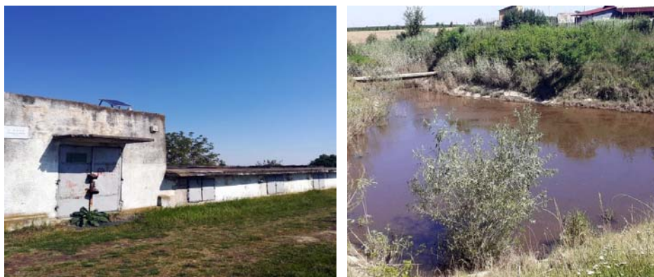
Figura 5.21. Stația de pompare Șag(Parța)
