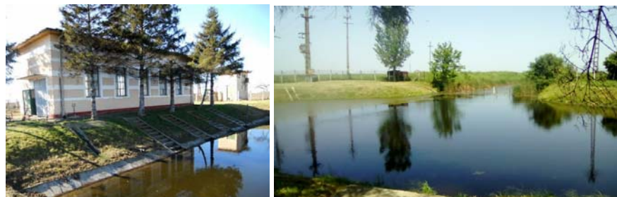
Figura 5.54. Stația de pompare Toager I
