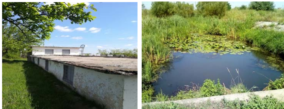
Figura 5.20. Stația de pompare Moșnița
