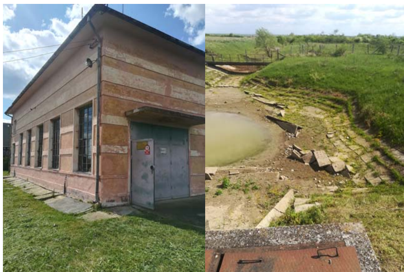
Figura 5.37. Stația de pompare Dicșani
