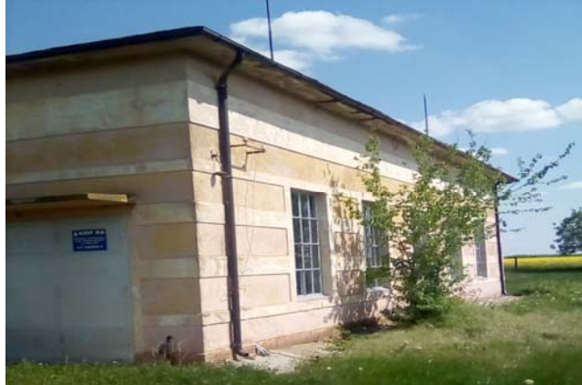
Figura 5.55. Stația de pompare Toager II
