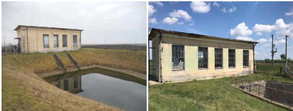
Figura 5.96. Stația de pompare Becicherec II
