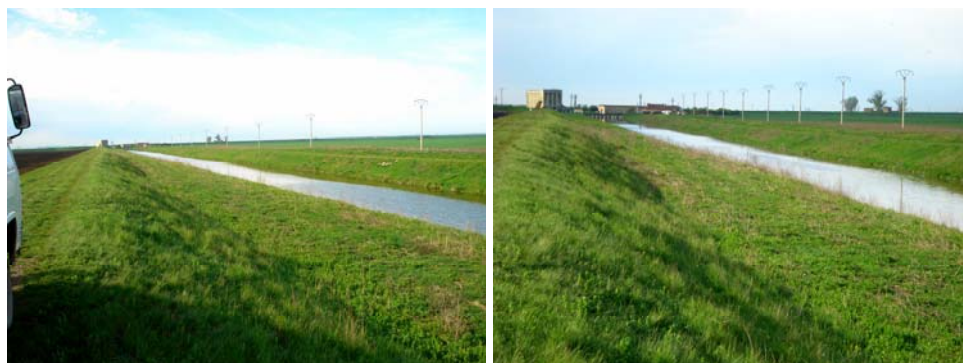
Figura 6.16. Canalul CPE și Acumularea de șes Cenei (dig Polder)
