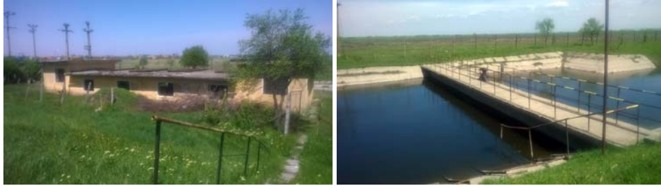
Figura 5.46. Stația de pompare Moravița
