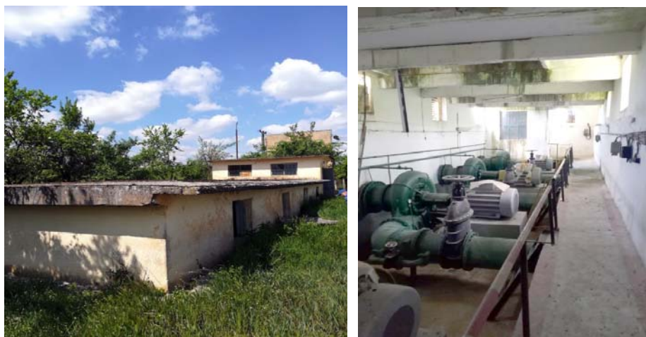
Figura 5.22. Stația de pompare Albina
