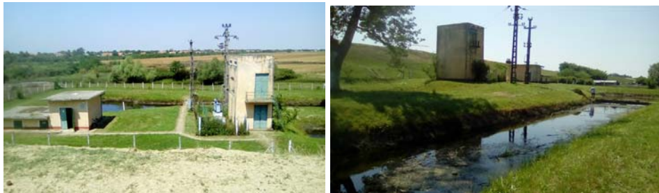
Figura 5.32. Stația de pompare Rudna Est
