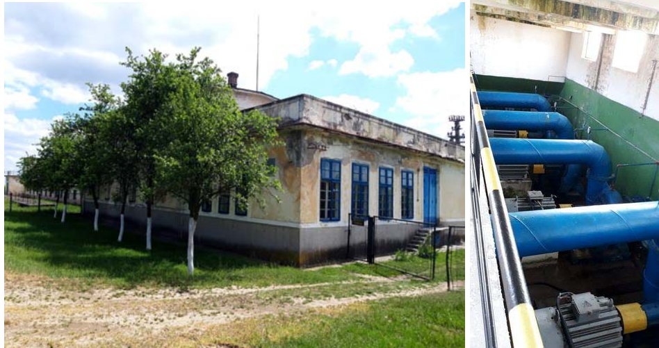
Figura 5.112. Stația de pompare Mureșan
