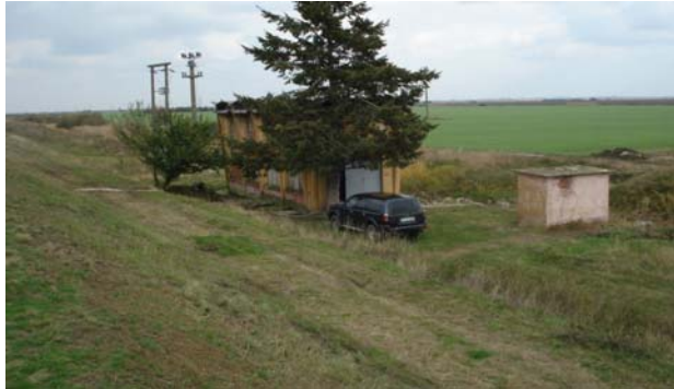
Figura 5.93. Stația de pompare Pustiniș
