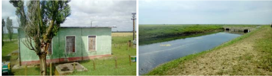
Figura 5.103. Stația de pompare Cheglevici mal stâng
