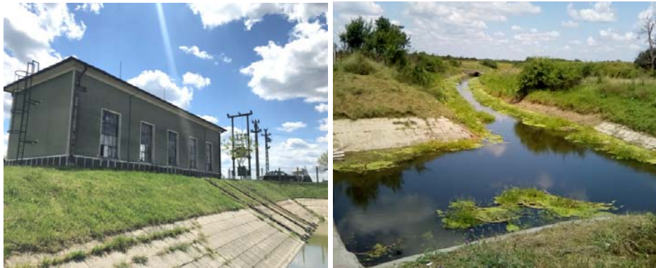
Figura 5.98. Stația de pompare Beregsău I
