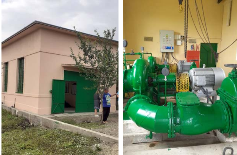
Figura 5.13. Stația de pompare Chizătău, după reabilitare
