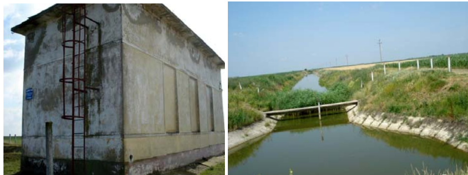
Figura 5.79. Stația de prepompare Comloș
