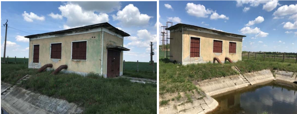
Figura 5.95. Stația de pompare Becicherec I
