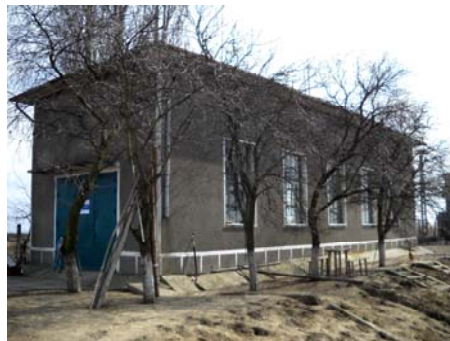
Figura 5.104. Stația de pompare Colonia Bulgară
