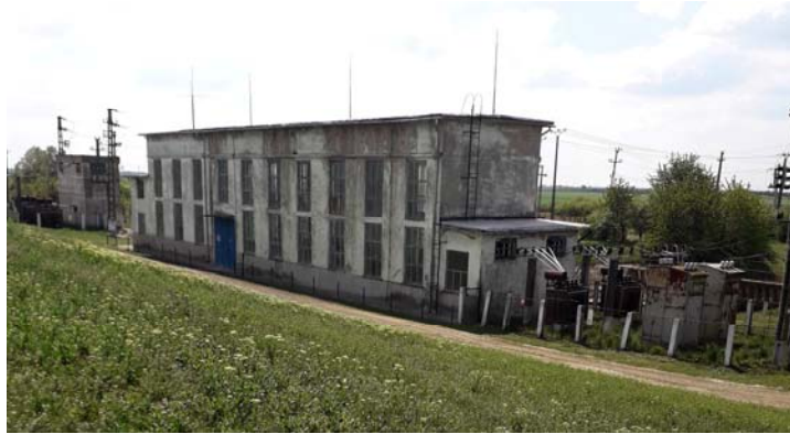
Figura 7.14. Stația de pompare Mureș
