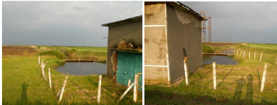
Figura 5.102. Stația de pompare Cheglevici mal drept
