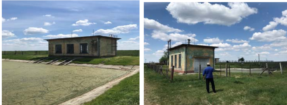
Figura 5.97. Stația de pompare Becicherec III
