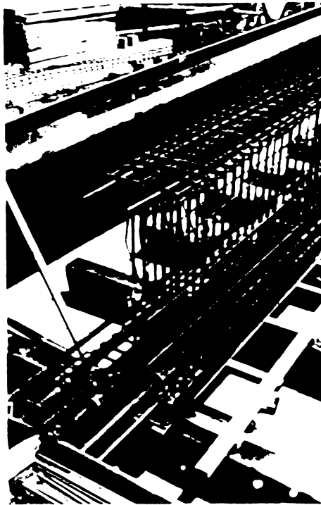
Foto 15. Detalii de armare la capăt
