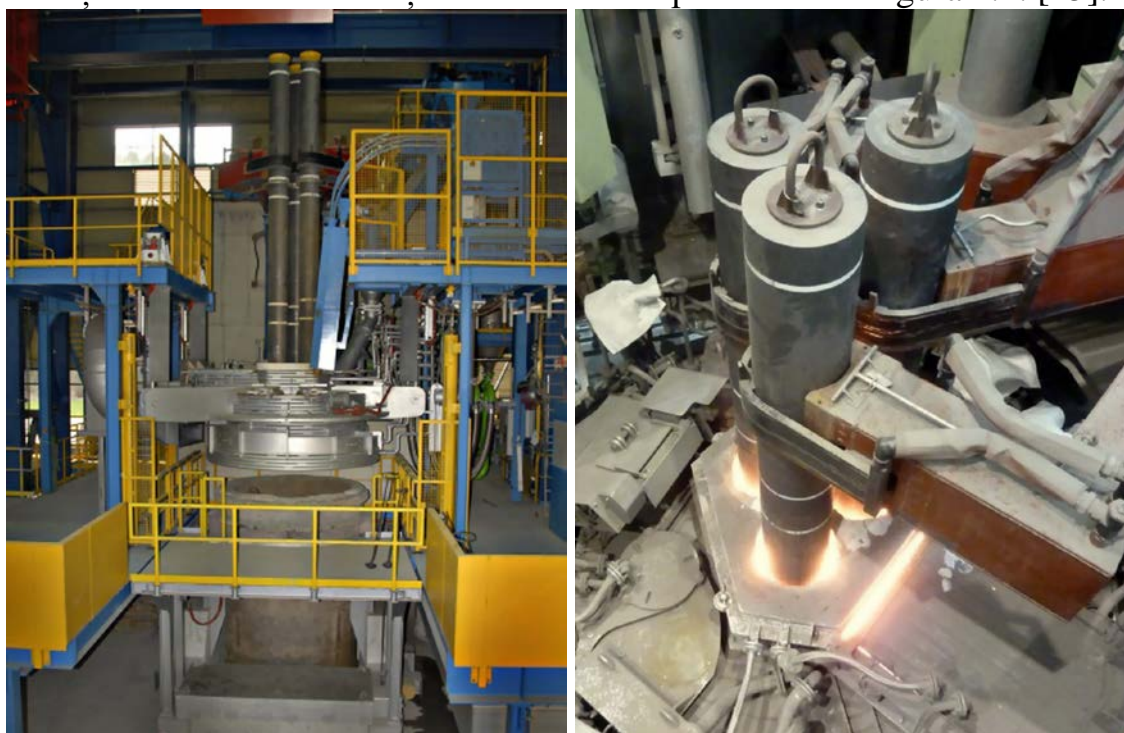
a) vedere generală
