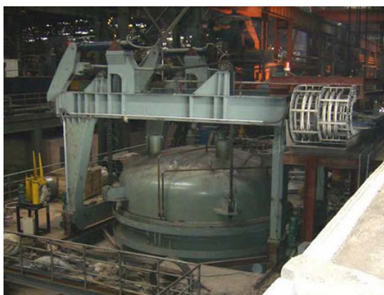
Fig. 2.6. Instalație de vidare VD vedere generală [53].
