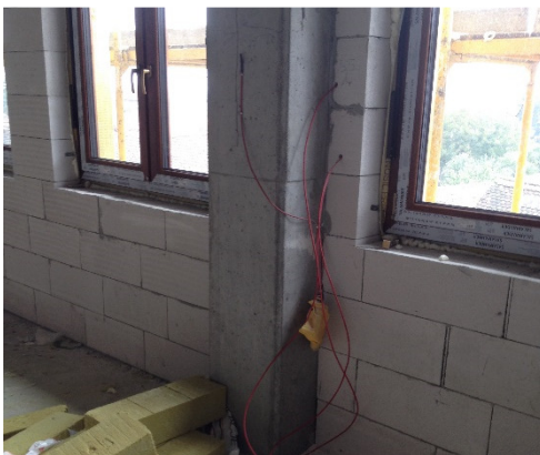
Figura 5.16 - Senzori pereți exteriori – stâlp intermediar 2: implementare
