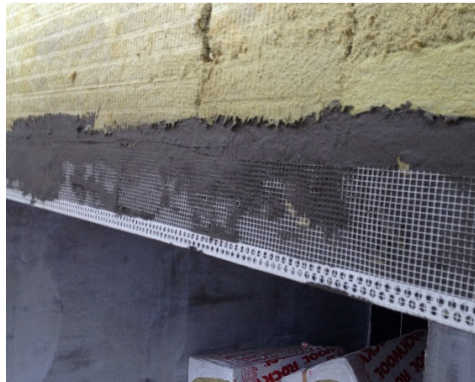
Figura 3.28 - Punți termice – grindă exterior intrare principală: detaliu și implementare
