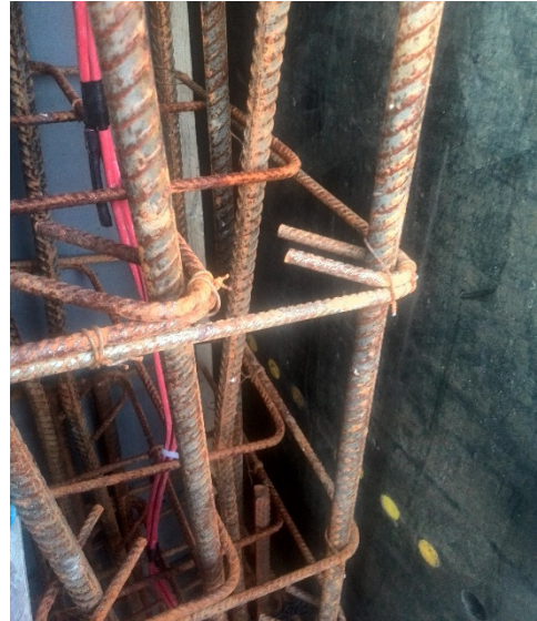
Figura 5.29 - Senzori stâlpi exteriori: detaliu și implementare
