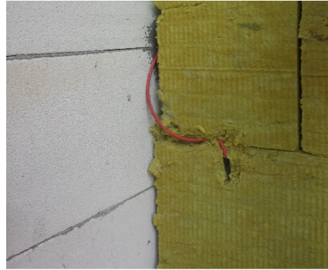
Figura 5.14 - Senzori pereți exteriori – colț intrând 2: implementare
