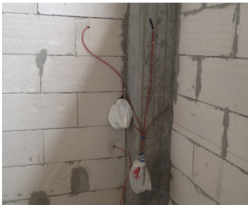
Figura 5.18 - Senzori pereți exteriori – colț ieșind spațiu neîncălzit 2: implementare
