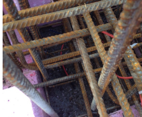
Figura 5.20 - Senzori planșeu pe sol – stâlp interior 1: detaliu și implementare
