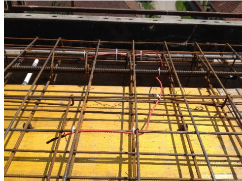
Figura 5.32 - Senzori planșeu spre pod – perete calcan 1: detaliu și implementare
