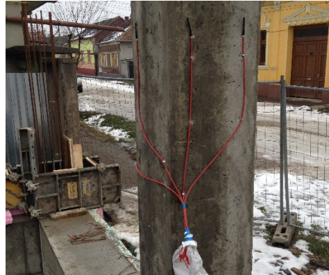
Figura 5.17 - Senzori pereți exteriori – colț ieșind spațiu neîncălzit 1: detaliu și implementare
