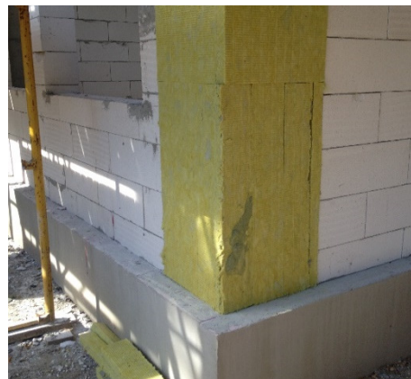
Figura 3.24 - Punți termice – stâlp exterior colț ieșind: detaliu și implementare
