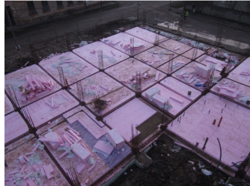
Figura 3.8 - Planșeu pe sol: detaliu și implementare
