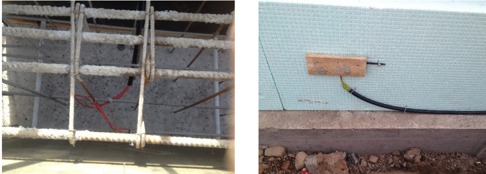
Figura 5.37 - Senzori fundații 2: implementare
