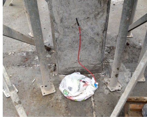
Figura 5.21 - Senzori planșeu pe sol – stâlp interior 2: implementare
