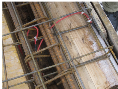
Figura 5.30 - Senzori planșeu inferior – grindă perimetrală: detaliu și implementare
