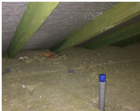
Figura 3.30 - Punți termice – cosoroabă pod: detaliu și implementare
