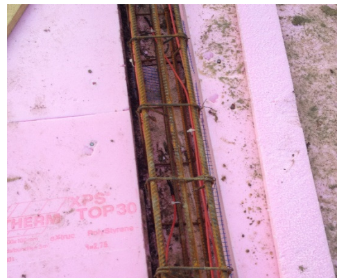
Figura 5.22 - Senzori planșeu pe sol – stâlp interior – grindă soclu: detaliu și implementare
