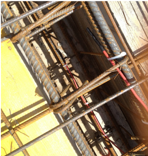
Figura 5.33 - Senzori planșeu spre pod – perete calcan 2: implementare
