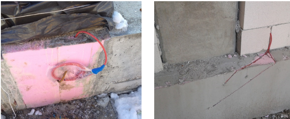
Figura 5.24 - Senzori planșeu pe sol – stâlp exterior 2: implementare
