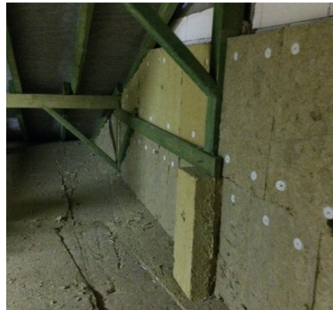
Figura 3.29 - Punți termice – perete calcan pod: detaliu și implementare
