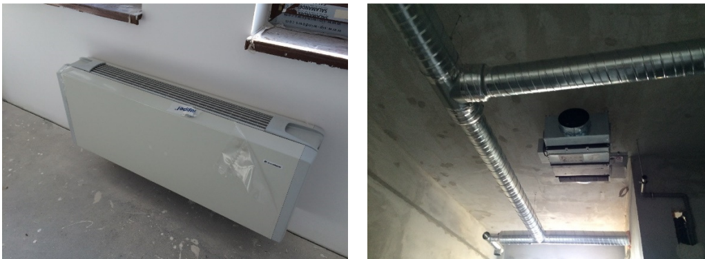
Figura 3.42 - Ventilconvectoare de pardoseală și tavan
