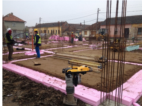
Figura 3.20 - Punți termice – soclu exterior: detaliu și implementare
