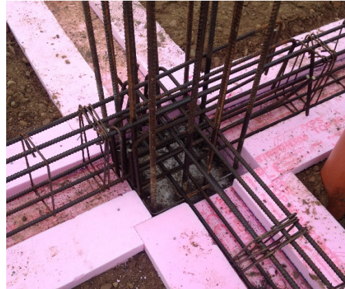
Figura 3.23 - Punți termice – stâlp interior bază: detaliu și implementare
