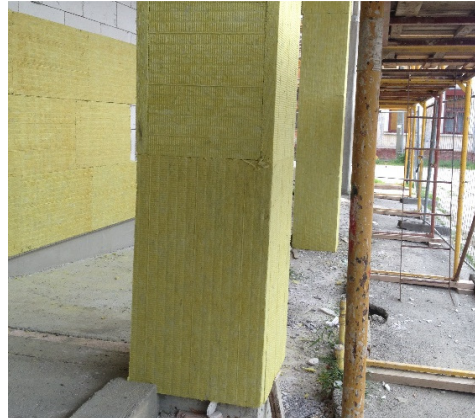
Figura 3.27 - Punți termice – stâlp exterior intrare principală: detaliu și implementare
