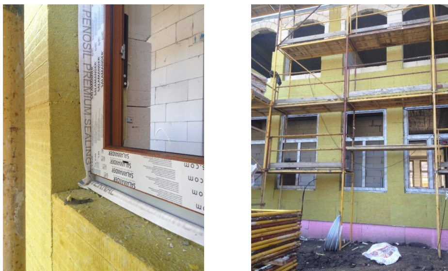
Figura 3.35 - Utilizarea benzilor de etanșare la montarea tâmplăriei
