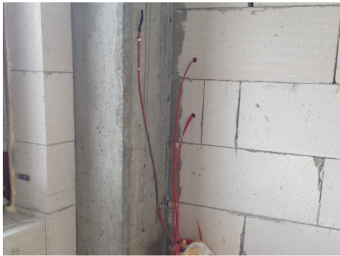
Figura 5.12 - Senzori pereți exteriori – colț ieșind 2: implementare
