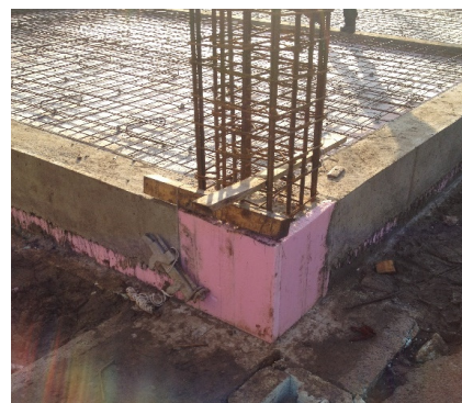
Figura 3.22 - Punți termice – stâlp exterior bază: detaliu și implementare
