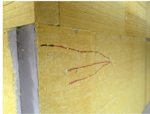
Figura 5.12 - Senzori pereți exteriori – colț ieșind 2: implementare
