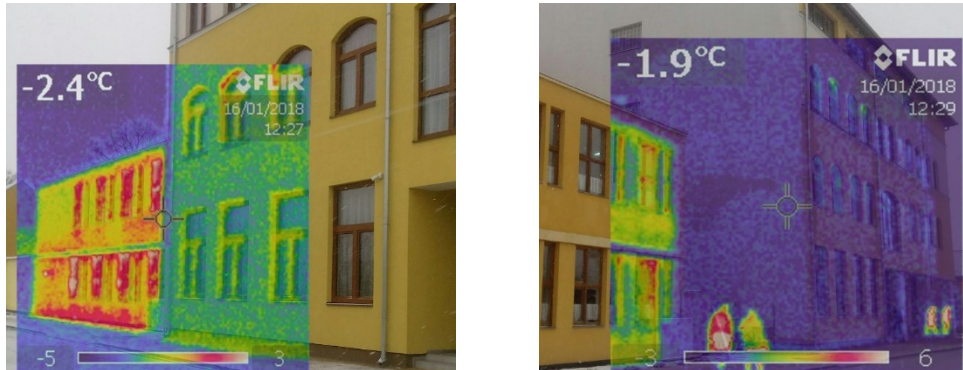
Figura 5.51 - Termografiere – comparație clădire vecină
