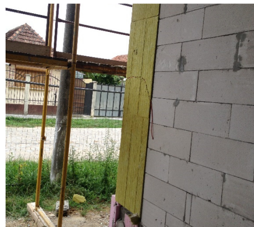
Figura 3.11 - Perete spre spațiu neîncălzit: detaliu și implementare
