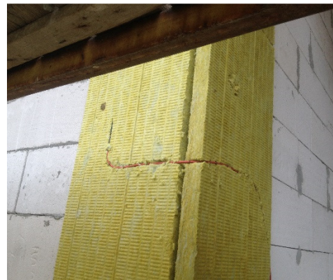
Figura 5.18 - Senzori pereți exteriori – colț ieșind spațiu neîncălzit 2: implementare
