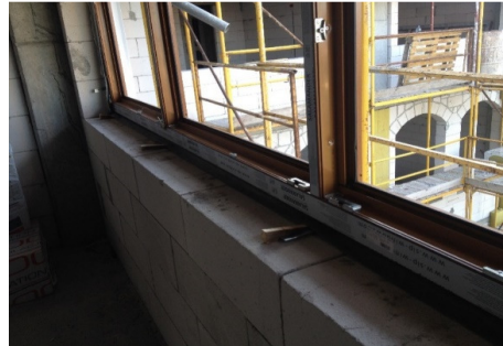
Figura 3.13 - Tâmplărie din profile PVC: detaliu și implementare
