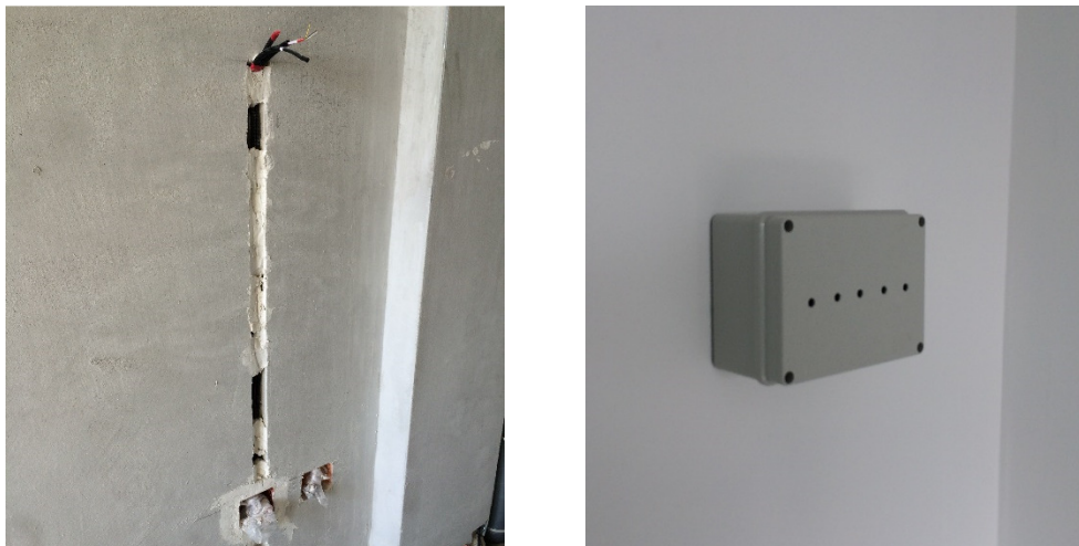
Figura 5.45 - Senzori parametrului confort interior
