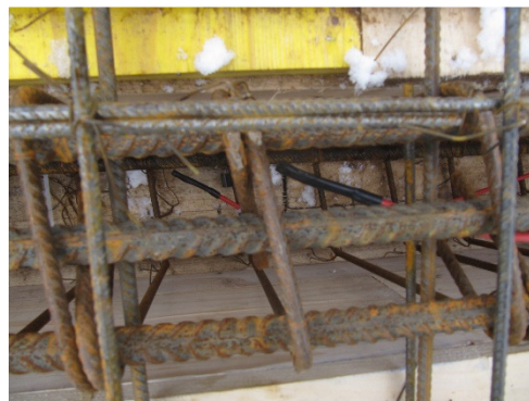
Figura 5.31 - Senzori planșeu inferior – grindă interioară: detaliu și implementare
