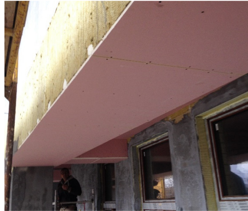
Figura 3.10 - Planșeu inferior: detaliu și implementare
