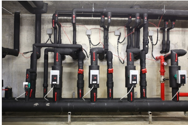
Figura 3.41 - Distribuitor și coloane principale instalații termice
