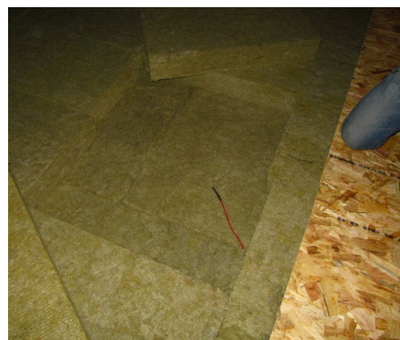
Figura 5.10 - Senzori planșeu spre pod: implementare
