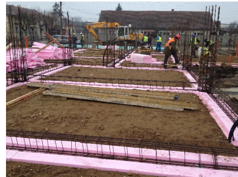
Figura 3.21 - Punți termice – soclu interior: detaliu și implementare
