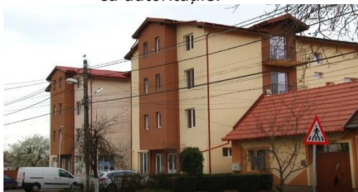
Figură Vatra veche Giroc - locuințe colective ( https://www.banatulazi.ro/orasul-de-la-marginea-timisoarei-in-top-10-national-ca-numar-de-locuinte-construite-video/ )
