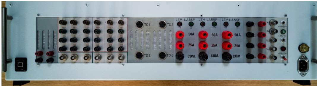
Fig. 5.8. Panoul frontal de conexiuni al sistemului de achiziție și prelucrare de date dedicat testării mașinilor electrice de putere mare realizat în cadrul P5
