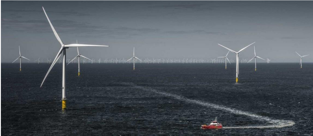
Fig. 1.8. Turbine eoliene V164-8MW în parcul eolian Burbo Bank 2 [W8]
