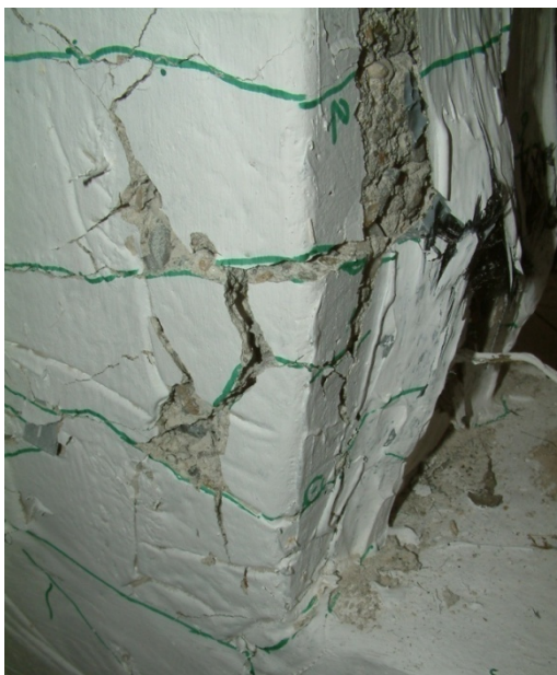
Figura 4.89. Zdrobirea betonului comprimat pentru elementul C8C1-CSS-AF(D1 = 36mm)
