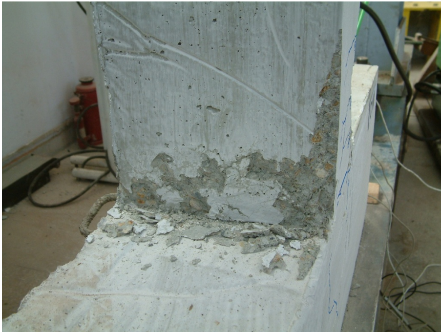
Figura 4.17. Detaliu zdrobire beton în zona comprimată pentru elementul C1M (35kN)
