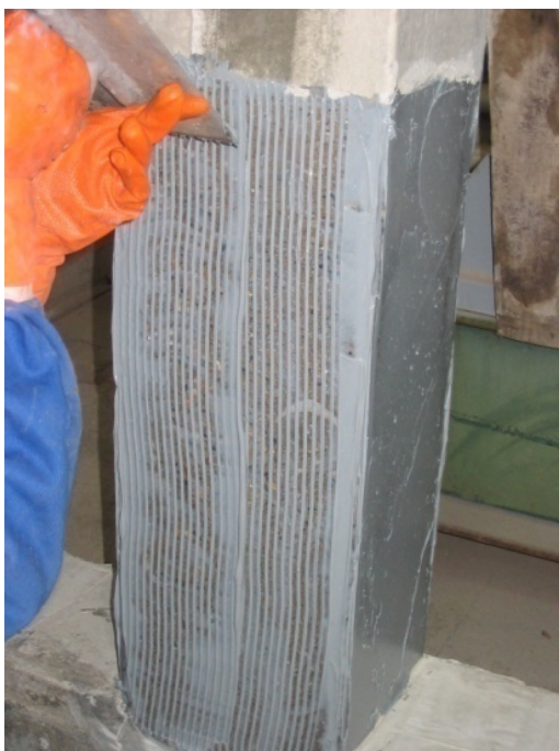
Figura 4.2. Aplicarea și uniformizarea rășinii epoxidice
