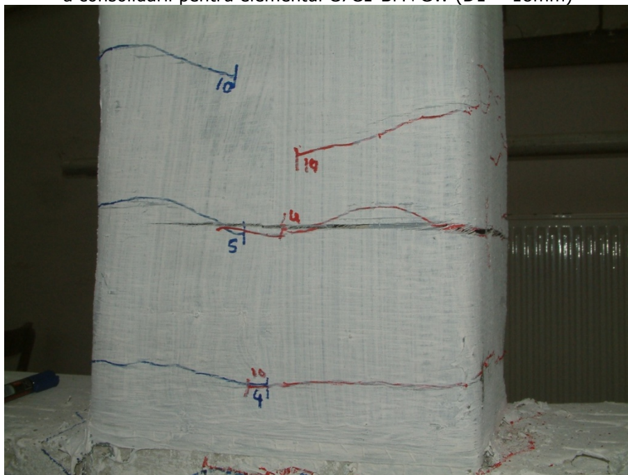
Figura 4.127. Inițierea degradării fibrei de înfășurare pentru elementul C7C1-BM+GW
