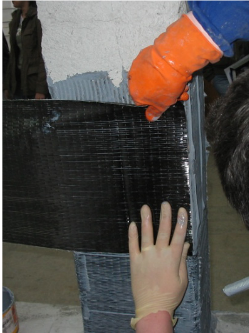
Figura 4.3. Aplicarea țesăturilor de înfășurare
