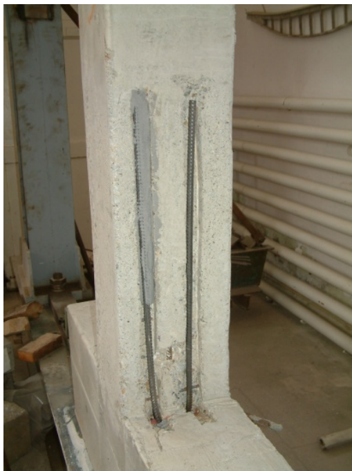
Figura 4.4. Aplicarea barelor laterale din oțel
