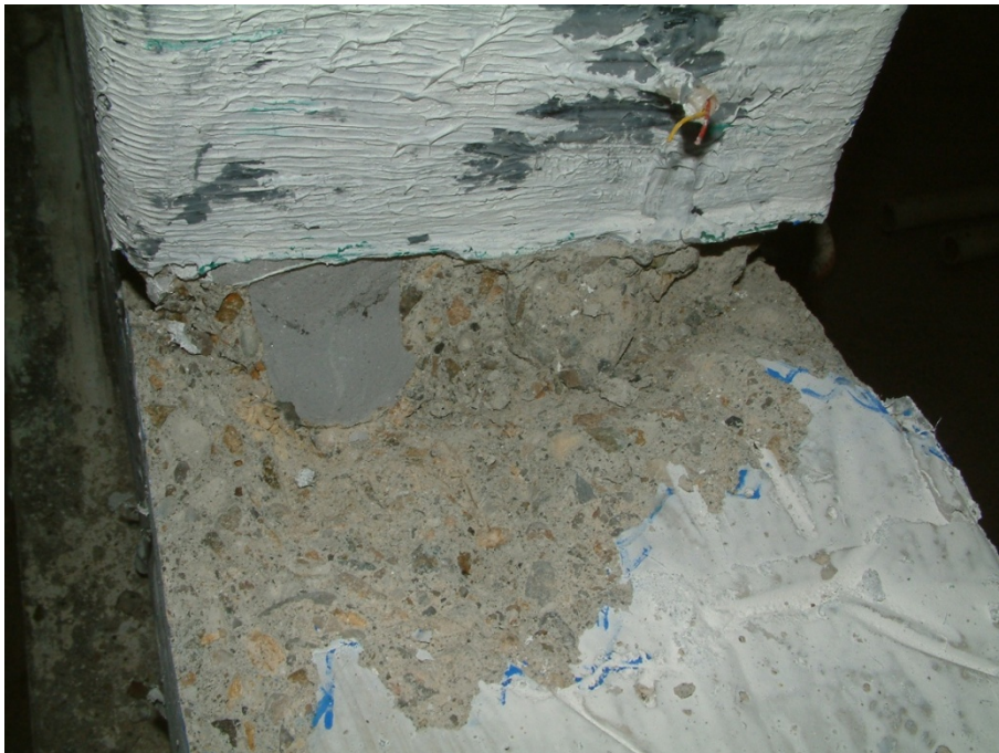
Figura 4.121. Detaliu după decopertare pentru elementul C4C-BM+CW
