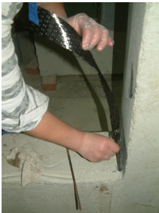
Figura 4.5. Aplicarea mănunchiurilor laterale din fibră de carbon
