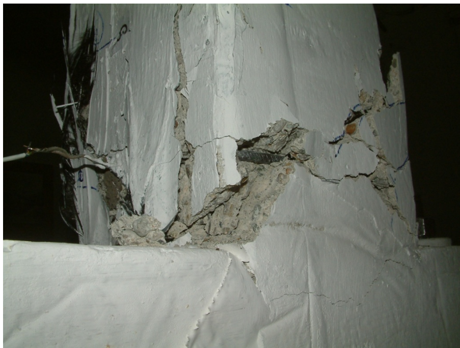
Figura 4.98. Zdrobirea betonului comprimat pentru elementul C8C2-CSS-AF ( D1 = 60\text{mm} )
