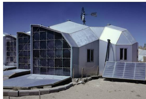
Fig. 2.10. Casa cu sistem energetic hibrid solar-eolian
