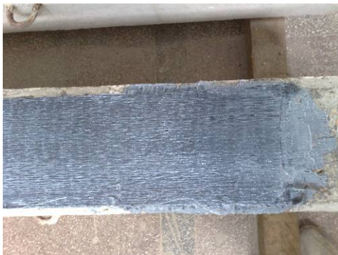
Aplicarea și impregnarea fâșiei longitudinale
