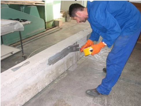
Aplicarea rășinii pe suprafața betonului
