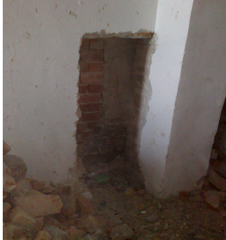
Spargerea zidăriei în jurul stâlpului
