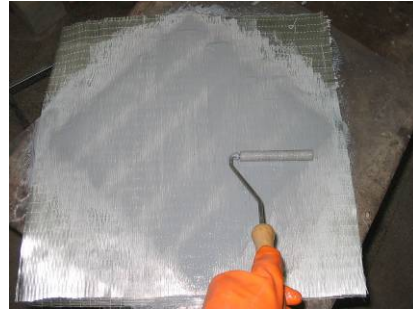
Așezarea țesăturii la 135° față de lamelă și impregnarea prin roluire
