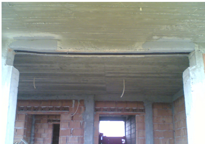
Aplicarea lamelei și pregătirea capetelor pentru țesătură
