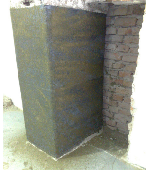
Confinarea stâlpului de la parter cu țesătură
