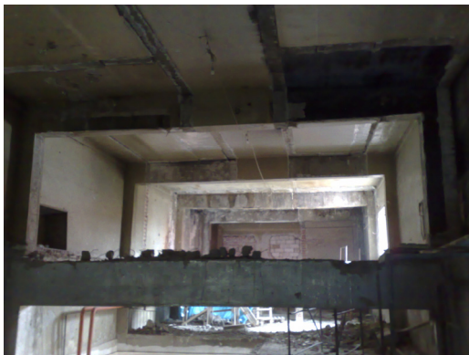
Grinda transversală de la etajul 1 ce urma a fi demolată
