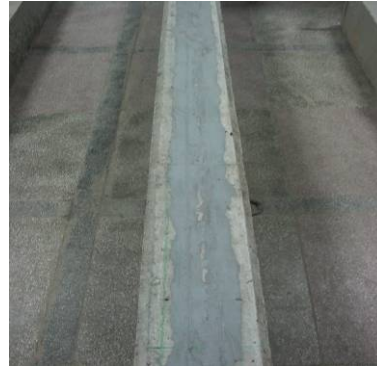
Nivelarea suprafeței cu șpaclul
