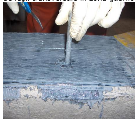
Străpungerea fâșiilor pentru introducerea ancorajelor
