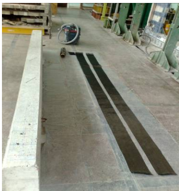
Grinda șlefuită, aspirată; găurile pentru ancoraje; fâșiile longitudinale
