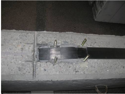
Înlăturarea plăcuțelor metalice de fixare după întărirea rășinii
