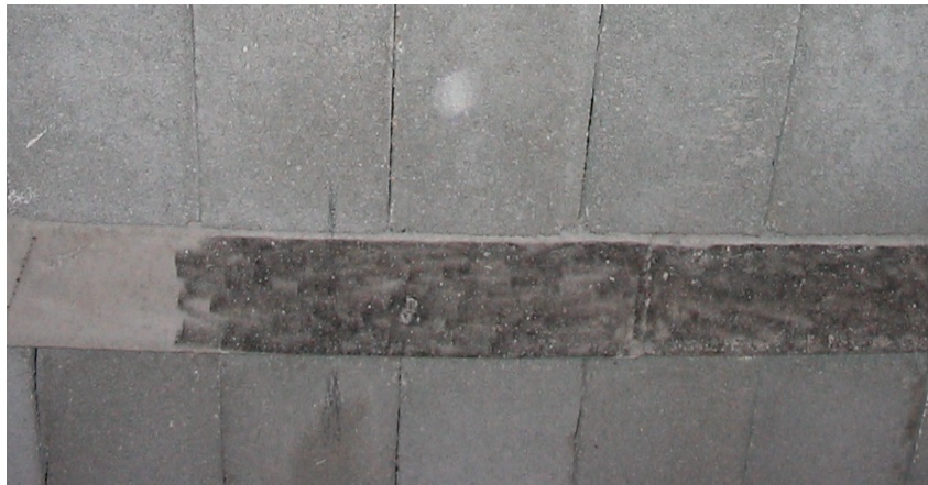
Curățarea suprafeței prin șlefuire și apoi suflare cu aer comprimat
