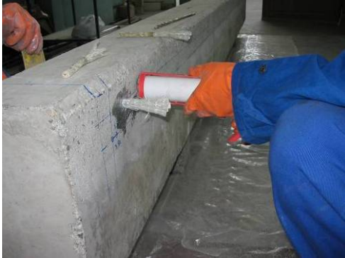
Umplerea găurilor cu rășină și introducerea ancorajelor
