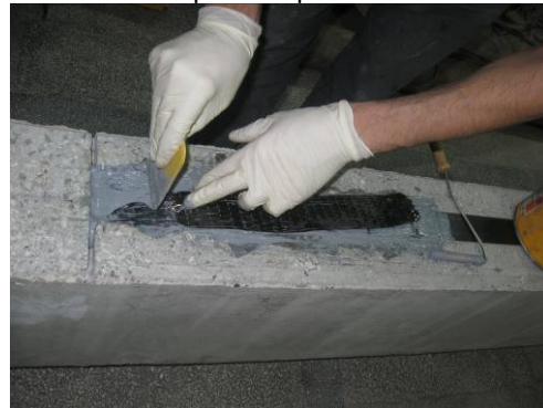
Aplicarea celui de-al doilea ancoraj pe capăt
