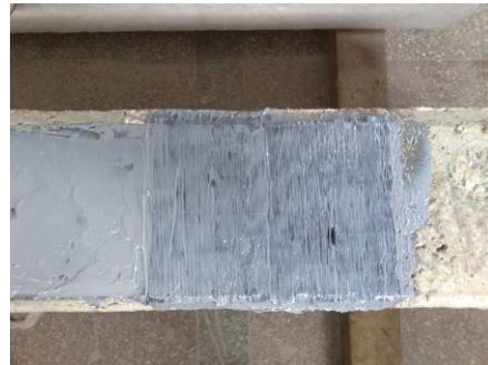
Aplicarea și impregnarea fâșiilor transversale în zona găurilor
