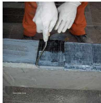
Aplicarea și impregnarea primului strat de fâșii transversale în zona găurilor
