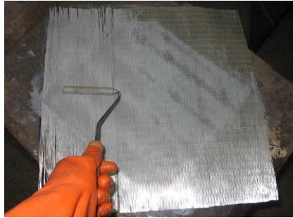
Așezarea țesăturii la 45° față de lamelă și impregnarea prin roluire
