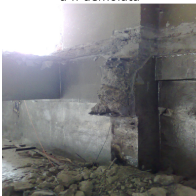
Grinda transversală de la etaj demolată
