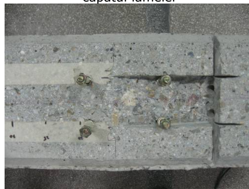
Găurile de ancorare și buloanele de prindere provizorie (conexpanduri)
