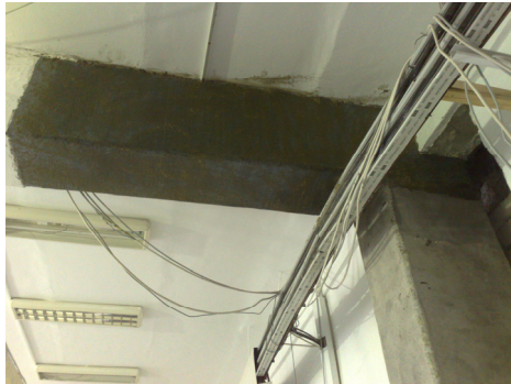
Capăt grindă parter, consolidat cu țesătură
