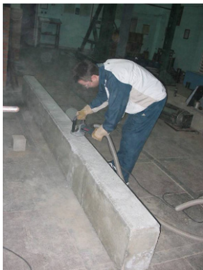
Șlefuirea suprafeței betonului
