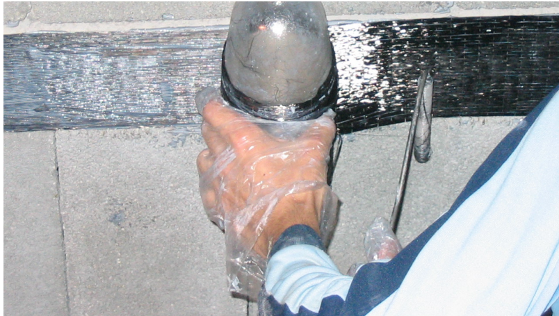
Aplicarea țesăturii din fibre de carbon în strat dublu
