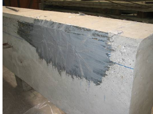
Răsfirarea țesăturii din capătul ancorajului și impregnarea ei
