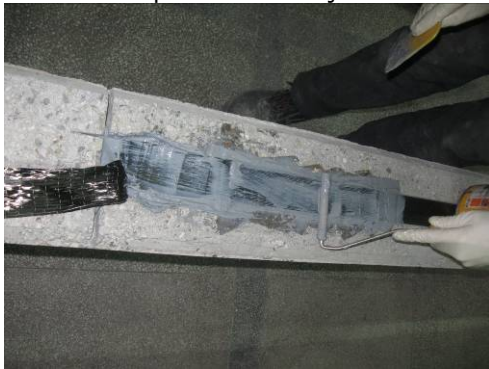
Aplicarea primului ancoraj pe capăt
