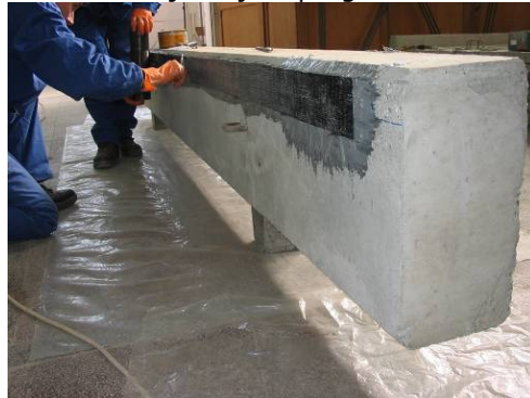
Aplicarea țesăturii longitudinale și impregnarea ei prin roluire
