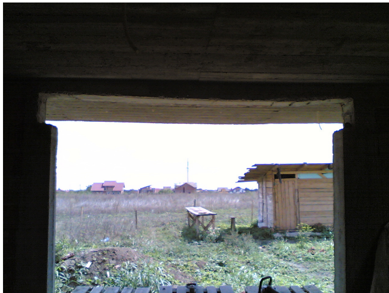
Figura 8.1. Starea structurală după înlăturarea buiandrugului
