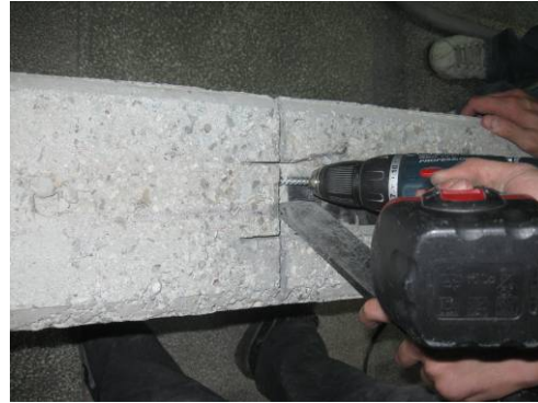
Curățarea găurilor prin periere și aspirarea prafului
