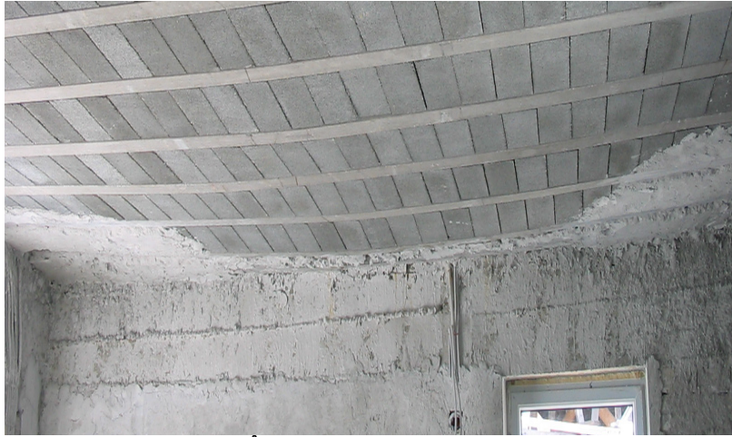
Înainte de consolidare
