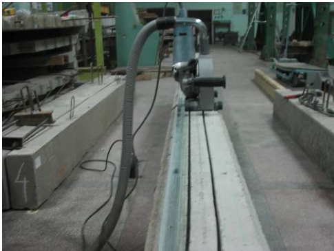
Tăierea șlițurilor în beton și aspirarea lor
