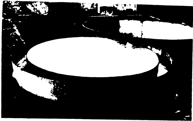
Foto Nr.2 - Deversorul de prea- plin al rezervorului de alimen- tare
