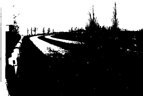
Fig. I.7.a. Covor asfaltic din mortar cu subif, executat în 1960 pe E.N. 59 km 15+900 și fotografiat în 1973
