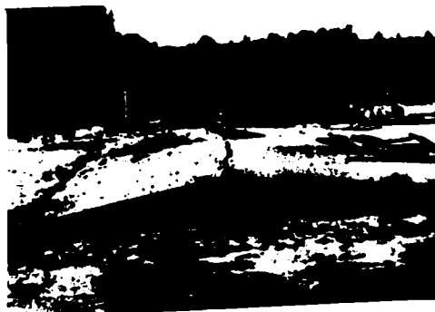
b) Distrugerea datorită flambării la variații de temperatură (SUA)
