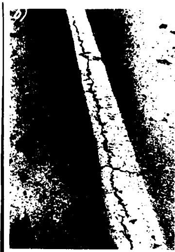
Fig.VI.36. Fisură longitudinală
