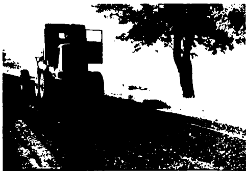
Fig. III.3. Aşternerea materialului omogenizat cu autogrederul
