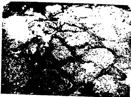
Fig.II.32 Suprafață falezată DN 6 Km 390+200
