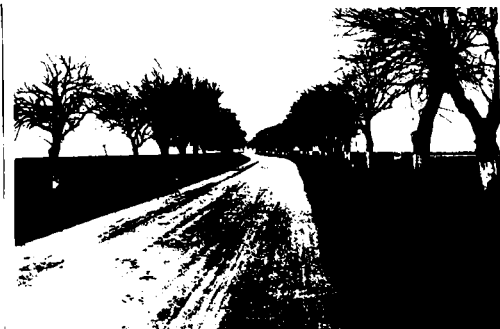
Fig. I.17. Un sector de drum dat în exploatare pe km 7 km 548
