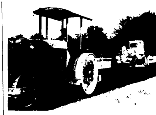
Fig. III.5. Cilindrarea pietruirii stabilizate
