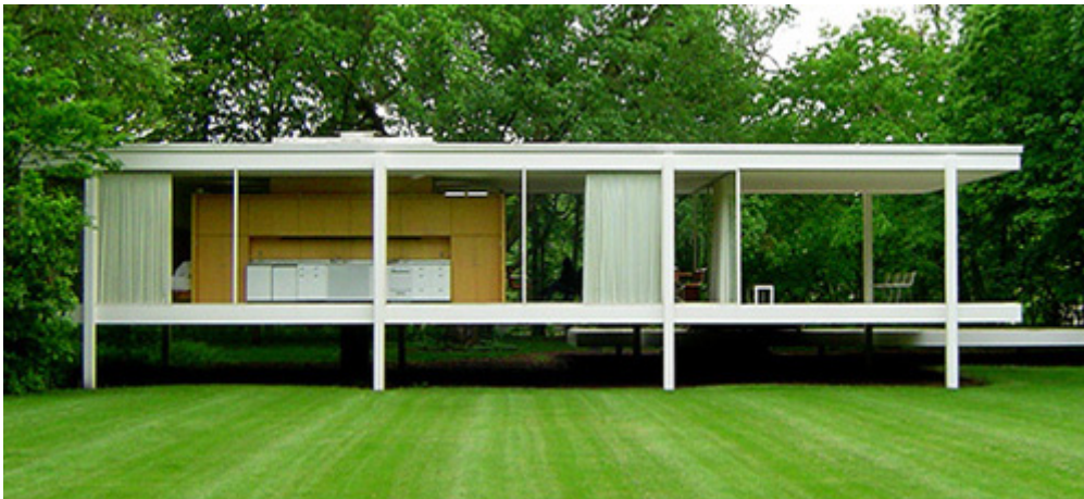
Fig. 4.65 Mies van der Rohe – Farnsworth House, 1951
