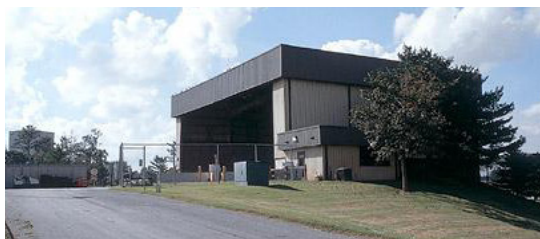
Fig. 2.38 Stație de transfer
