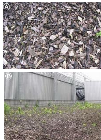
Fig. 3.17A, B Biofiltru la o stație de compostare
