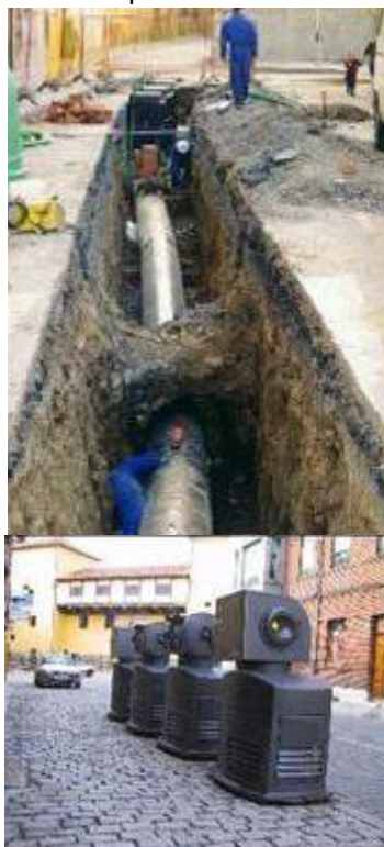
Fig. 2.35 Sistemul vacuumat de transport al deșeurilor în zona istorică a localității León, Spania
