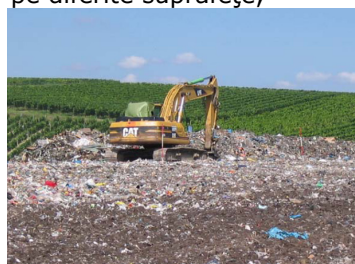
Fig. 3.54 Exemple de împrăștiere și compactare a deșeurilor în cadrul unui depozit
