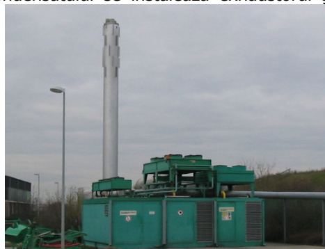
Fig. 3.53 Sistem de valorificare a gazului de depozit
