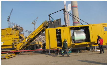
Fig. 5.6 Instalația de balotare a deșeurilor menajere de pe platforma CET Sud
