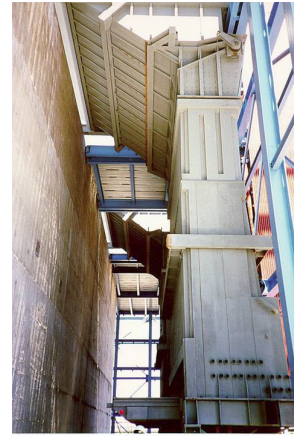
Fig. 3.27 Vedere până și puț de alimentare cu deșeuri a camerei de incinerare
