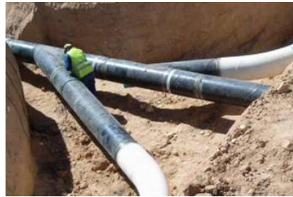
Fig. 2.30 Pozarea conductelor vacuumate
