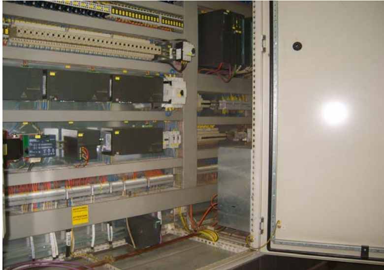
Fig. 6.29 Implementarea PLC-ului în schema reală de conducere a turnării continue
