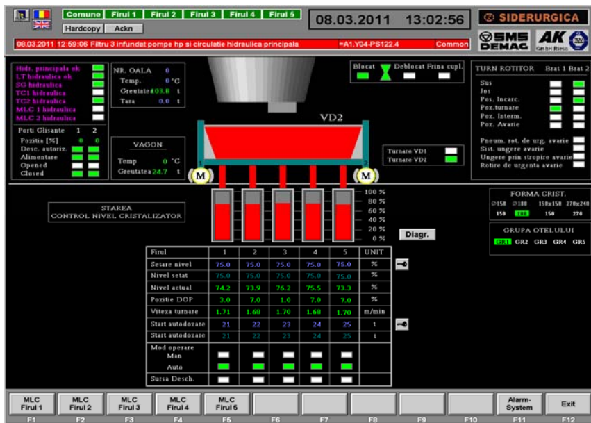
Fig. 6.7 Prezentarea parametrilor de funcționare în momentele când s-au făcut încercările pentru distribuitor, print – screen de pe sistemul SCADA al procesului industrial (A.M.-HD)
