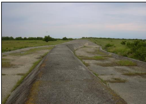
Fig. 4.41: Deversor admisie din râu Timiș
