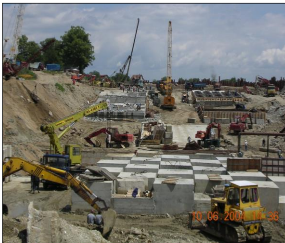
Fig. 4.31: Lucrări de reparație a pragului deversor Coștei
