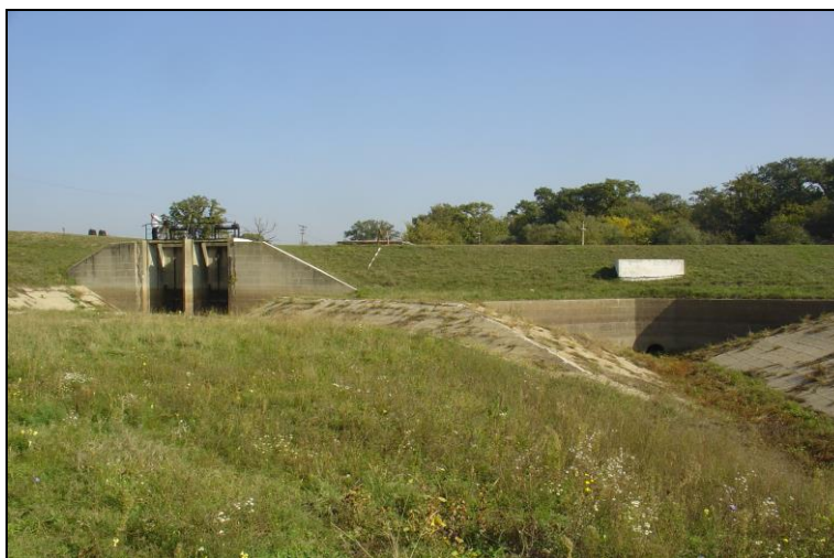
Fig. 3.11: Acumularea laterală nepermanentă (polderul) Gad pe râul Timiș (foto: Cătălin Aldescu)
