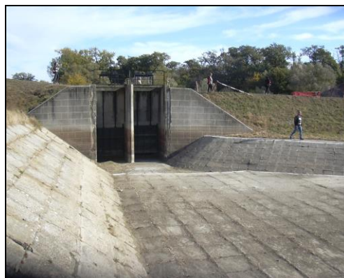
Fig. 4.54: Conducta de evacuare gravitațională
