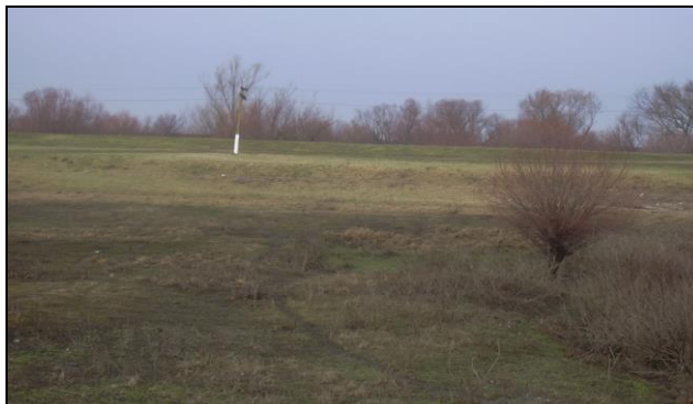
Fig. 4.52: Dig de izolare polder Gad
