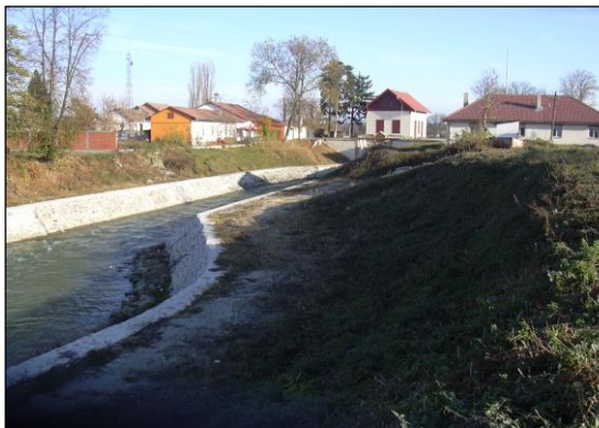
Fig. 4.37: Canalul de acces la disipator
