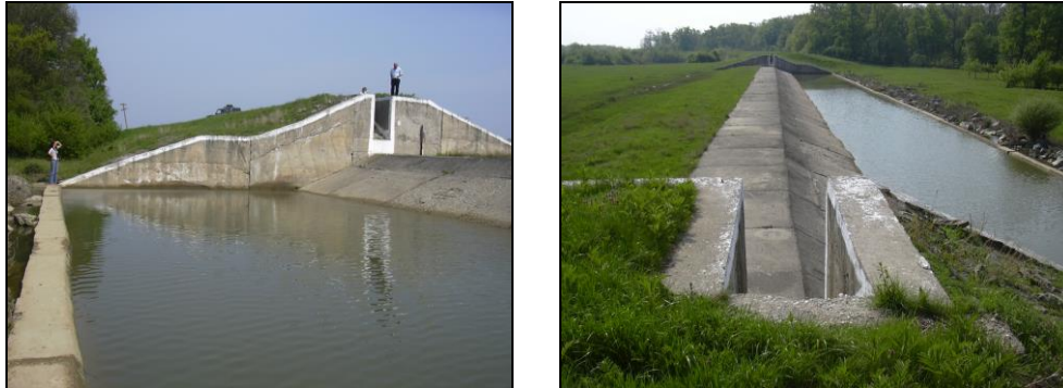
Fig. 4.45: Deversor reversibil de admisie acumulare Pădureni
