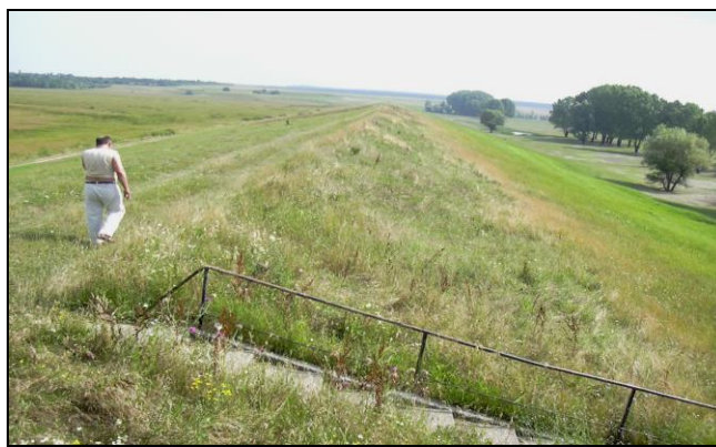
Fig. 4.47: Corp baraj acumulare Cadar-Duboz
