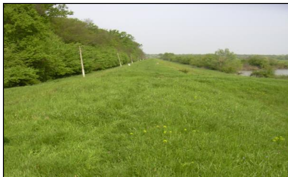
Fig. 4.44: Dig acumulare Pădureni
