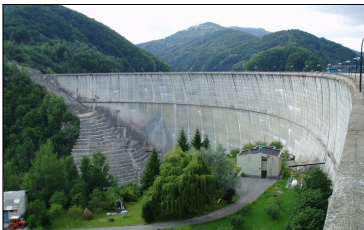
Fig. 3.7: Barajul Paltinu pe râul Doftana [sursă: www.google.ro]
