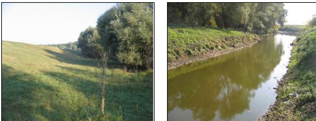
Fig. 5.6: Polder Pădureni și canal de drenare în polderul Pădureni
