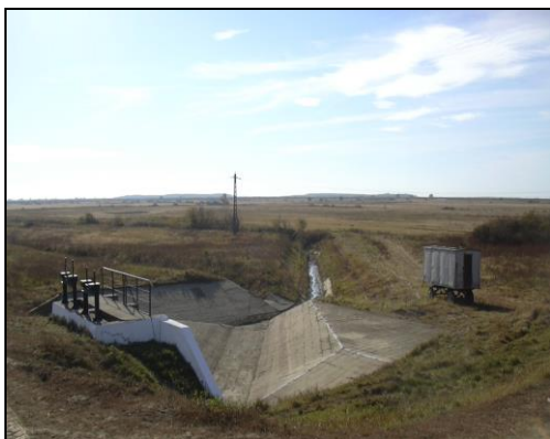
Fig. 4.53: Conducta principală de golire a rezervorului
