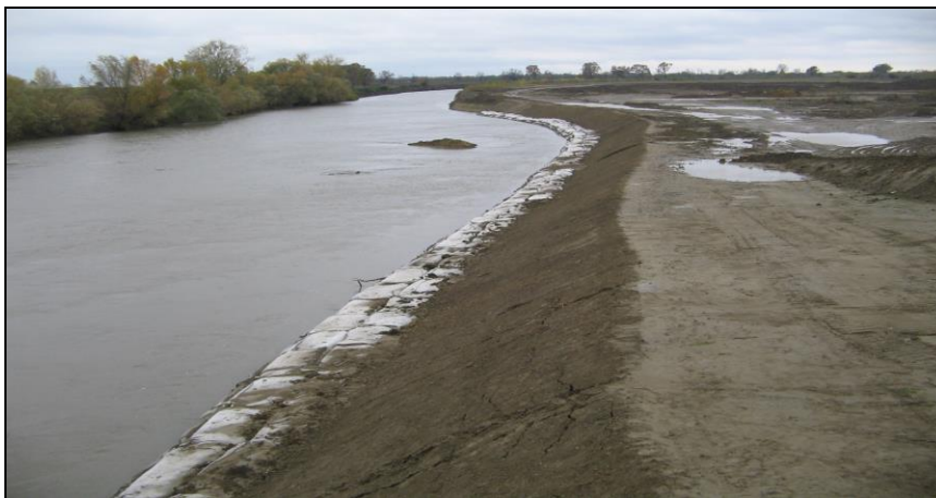
Fig. 4.30: Consolidare și supraînălțare de dig la Cebza, râul Timiș (foto: Cătălin Aldescu)
