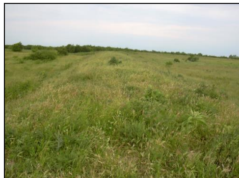
Fig. 4.40: Dig mal drept râu Timiș
