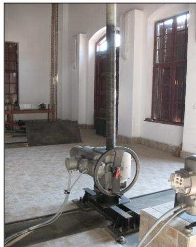
Fig. 4.36: Mecanism acționare stăvilărilor
