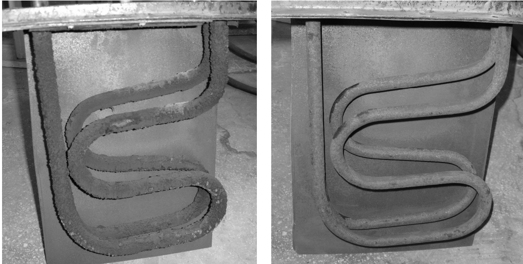
Figura 6.14. Țevile din corpul convectiv înainte și după curățare
