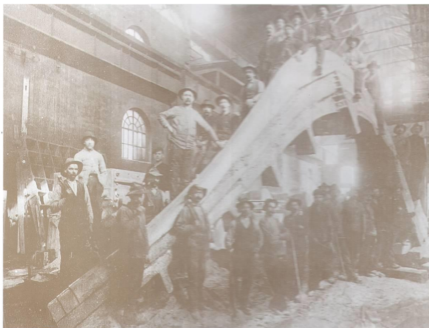
Etrava cuirasatului austriac "Viribus Unitis" fabricată la Reșița în 1905. Stem of Austrian battle-ship "Viribus Unitis" manufactured in Reșița at 1905.
