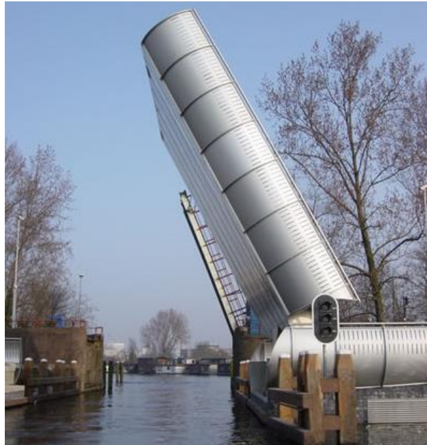
Fig. 2. 25. Riekerhaven bridge (Amsterdam)
