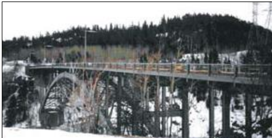
Fig. 2. 14. Arvida bridge (Quebec, Canada)
