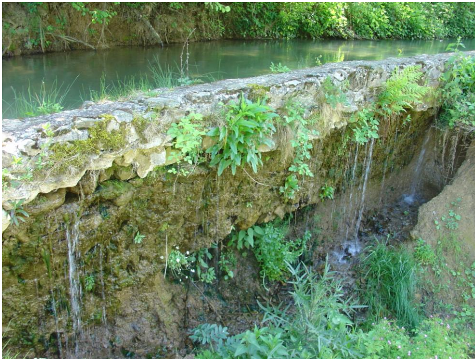
Fig. 5.6. Canal aducțiune MHC1 – tronsonul 1
