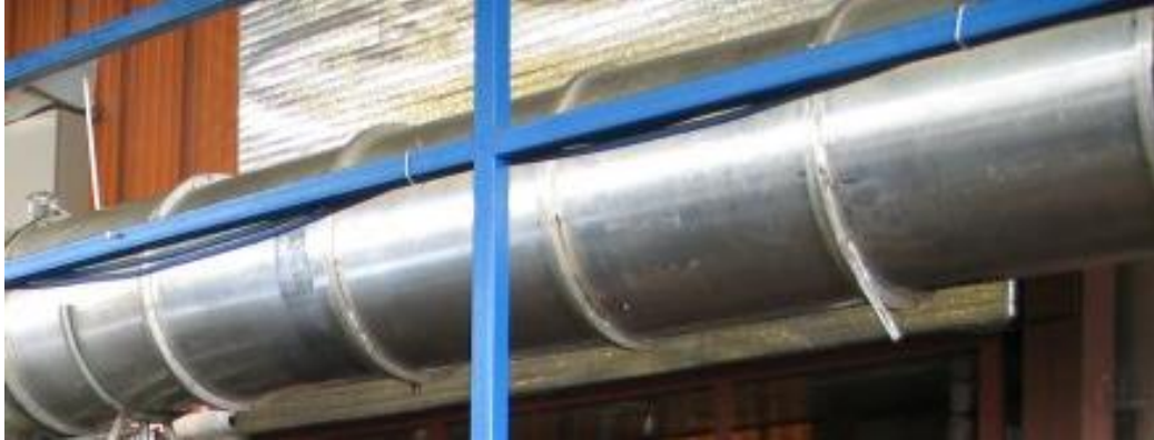
Fig.7.3. Canalul izolat cu mantaua de protecție
