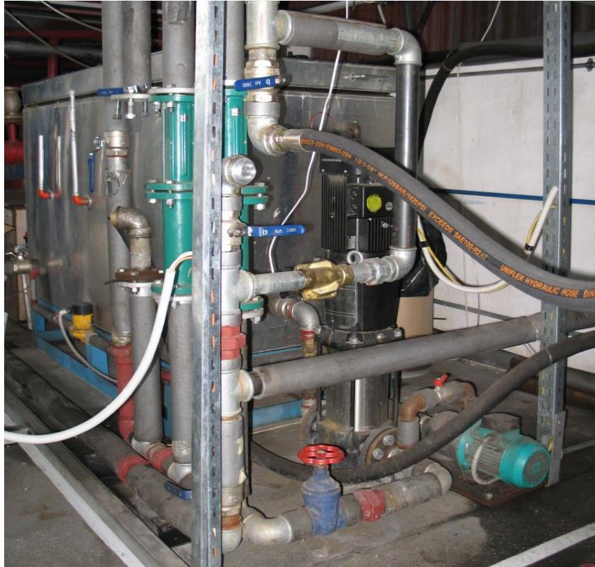
Fig.7.9. Montaj pompa de apă Grundfos
