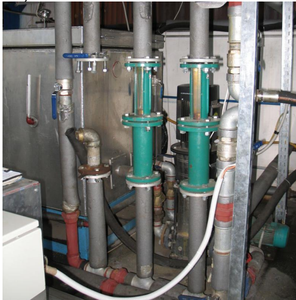
Fig.7.14. Montaj debitmetre de apă
