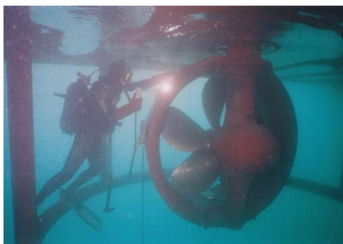
Figura 1.15. Repararea duzei la elicea unei corvete.
