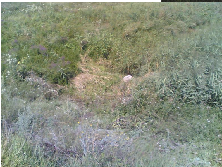
Fig.7.4 Vedere aval descărcător de ape mari existent
