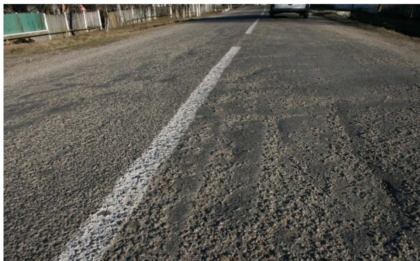
Fig.2.3. Suprafață exudată - DJ 673 km 39+220 - foto 6
