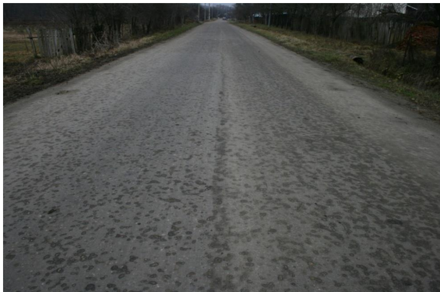
Fig.2.8. Suprafață cu ciupituri - DJ605A km 48+350
