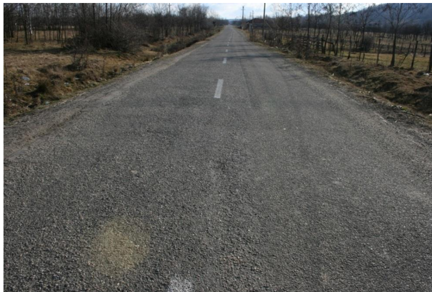
Fig. 2.7. Suprafață poroasă - DJ 607 km 27+282
