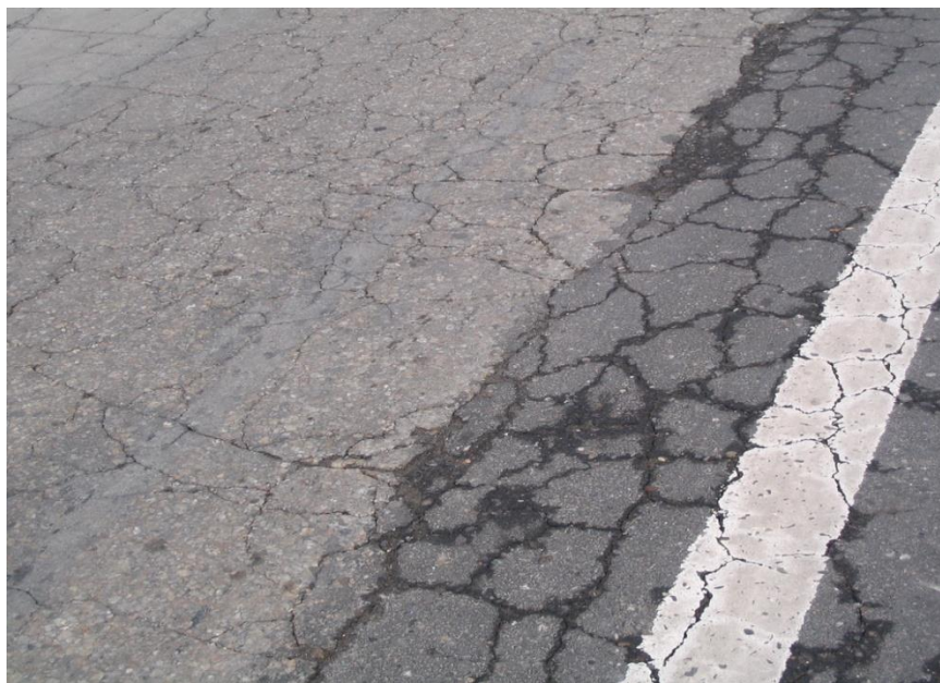
Fig. 2.14. Faianțări - DJ661 km 37+450
