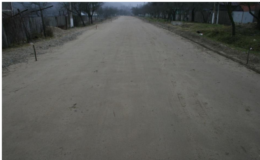
Fig.2.2. Suprafață șlefuită - DJ 605B km 12+100
