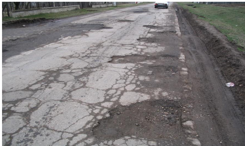
Fig. 2.15. Gropi - DJ 661 km 8+100
