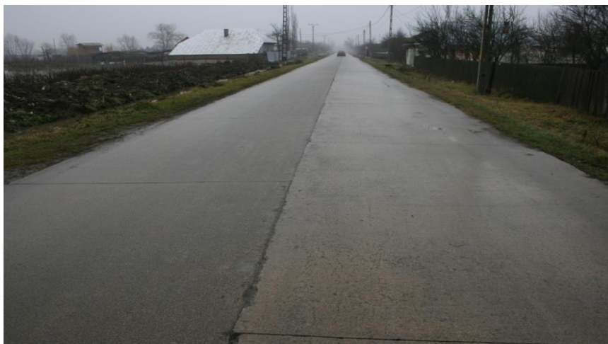
Fig.2.18. Suprafață șlefuită DJ 663A km 3+250
