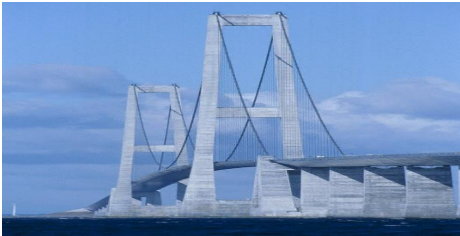
Fig. 3.8. Great Belt Link, Danemarca – grindă prefabricată
