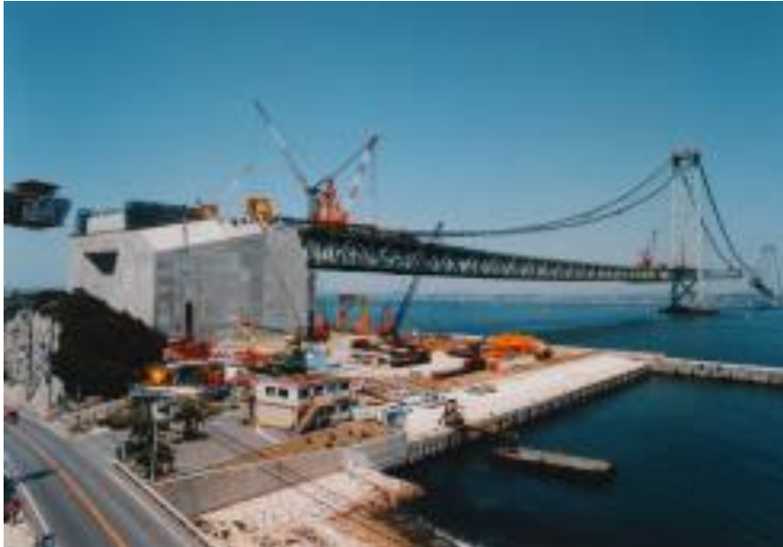
Fig.5.12. Ancorajul podului Akashi-Kaikyo Bridge
