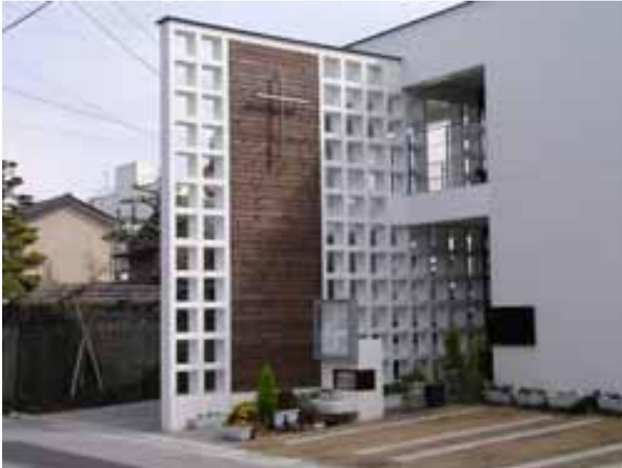
Fig.5.8. Zid rețea din beton autocompactant
