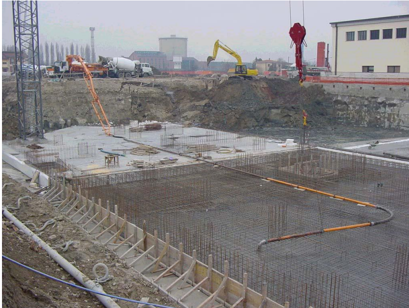
Fig.5.10. Turnarea unei plăci cu beton autocompactant –centru comercial, Ferrara, Italia
