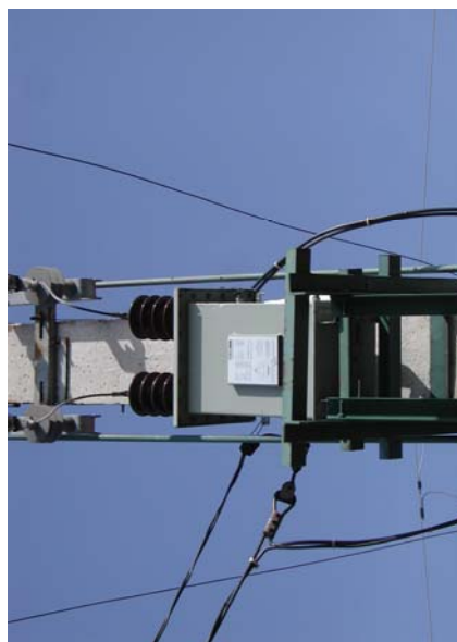
Fig. 6.16. PTA monofazat 20/0,23 kV, 15 kVA, Romos:
