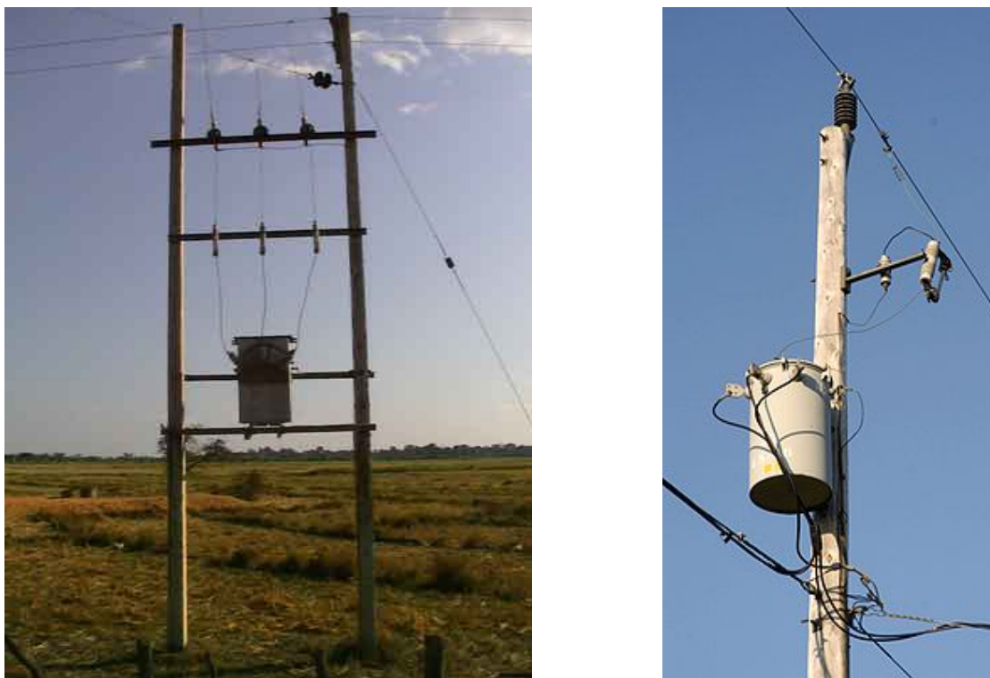
Fig. 2.13. Imagini cu elemente constructive ale sistemului SWER
