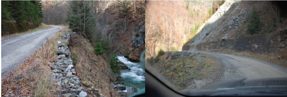
Figura 3. 21 Zone unde drumul forestier este apărat de ziduri de sprijin iar drumul spre râu este pe gabioane
