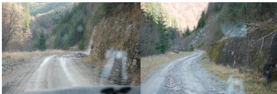
Figura 3. 23 Zone unde drumul forestier este apărat de ziduri de sprijin
