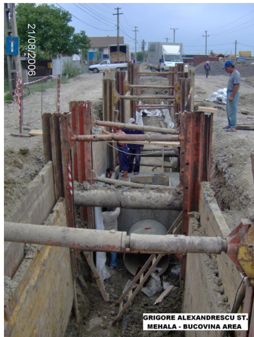
Figura 3. 33 Montaj conductă de canalizare în Municipiul Timișoara
