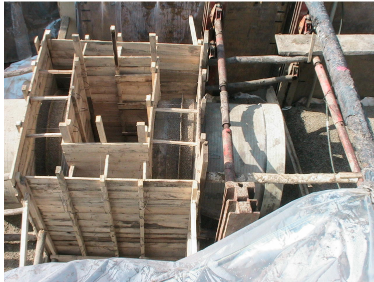
Figura 2. 15 Cofraj pentru execuție fundație cămin canal
