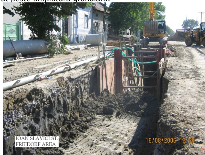
Figura 3. 31 Montaj conductă de canalizare în Municipiul Timișoara
