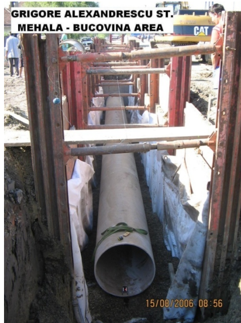
Figura 3. 30 Montaj conductă de canalizare în Municipiul Timișoara
