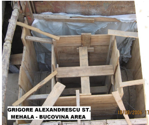
Figura 3. 32 Montaj conductă de canalizare în Municipiul Timișoara
