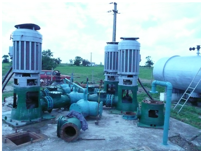
Figura 5.22 SPP 2 Semlac echipată cu pompe verticale de tip VDF (foto Cîmpan G.)
