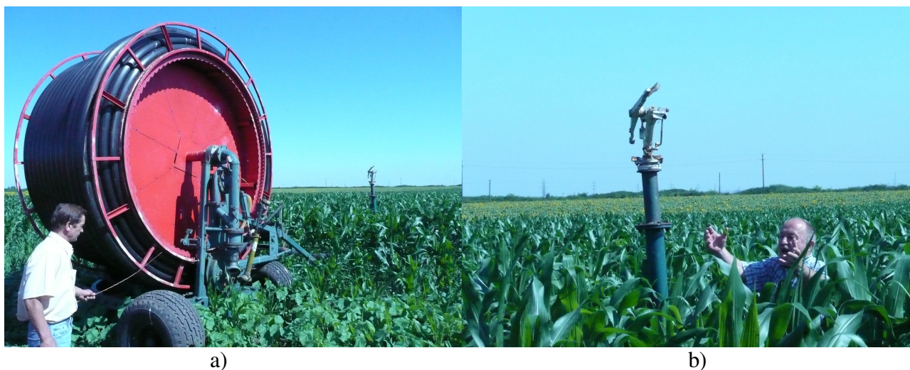
Figura 5.14 Instalație cu tambur și furtun, proprietate a firmei AGROGIL (foto Cîmpan G.) a) cadrul de susținere împreună cu tamburul; b) aspersorul tun de capăt
