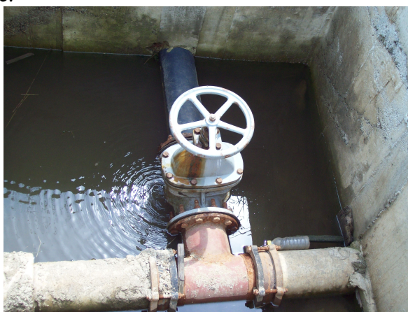
Figura 5.60 Racordul la rețeaua de distribuție -conducta secundară Cds 2 (foto Cîmpan G.)
