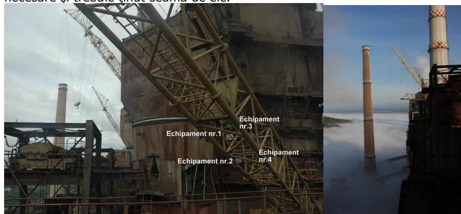
Fig 3.24 Patru echipamente wireless sincronizate pentru măsuratori la macaralele de serviciu de pe termocentrala Rovinari
