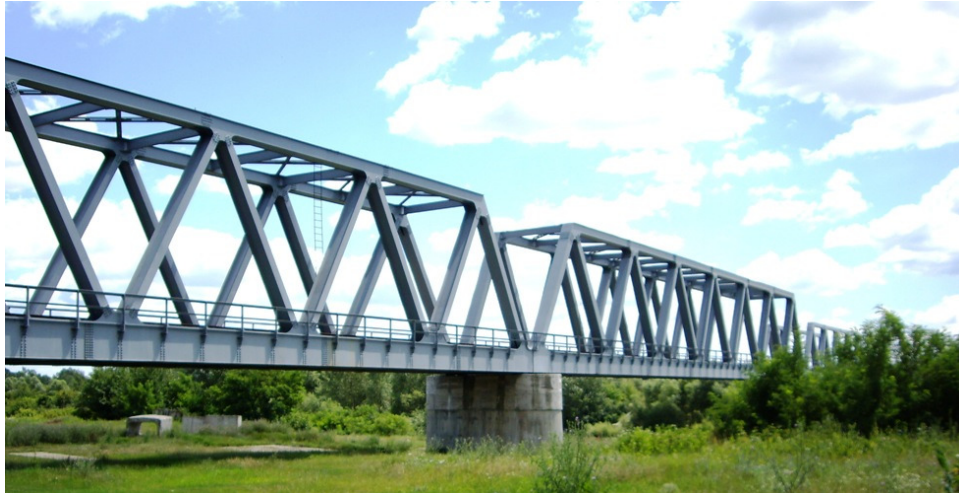
Fig. 2.2 Pod metalic de cale ferată (Șag-Timiș )
