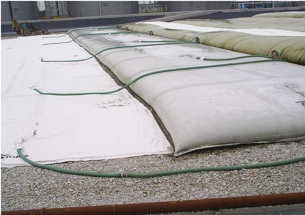
Fig. 6.14 - Depozitarea în sistem geotube Tencate
