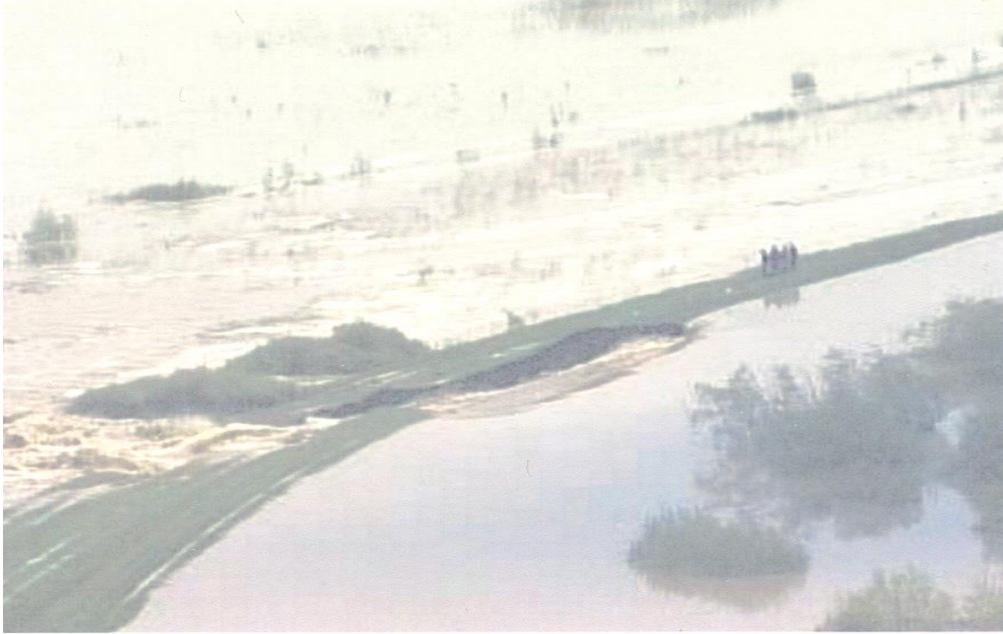
Fig. 4.48 - Ruptura de la km 6+500 pe râul Timiș la Crai Nou la viitura din aprilie 2005. Vedere din elicopter
