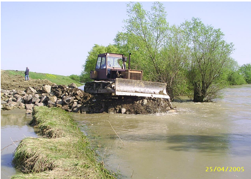
Fig. 4.53 – Începerea lucrărilor de închidere a breșei de la Crai Nou
