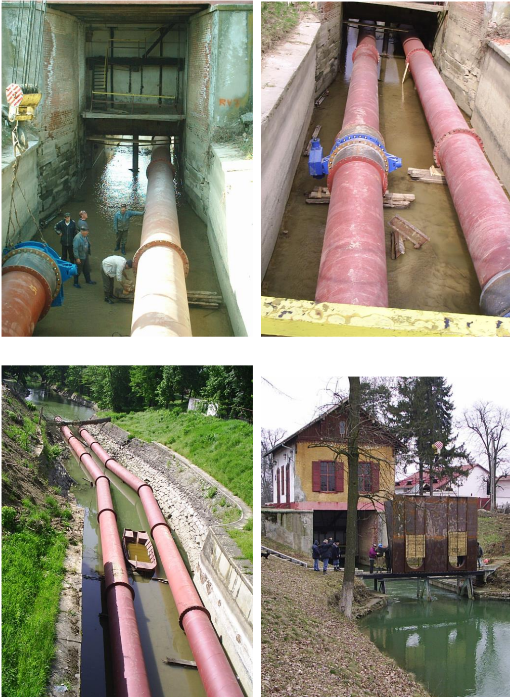
Fig. 7.3 - Conducta de tranzitare baraj Coștei
