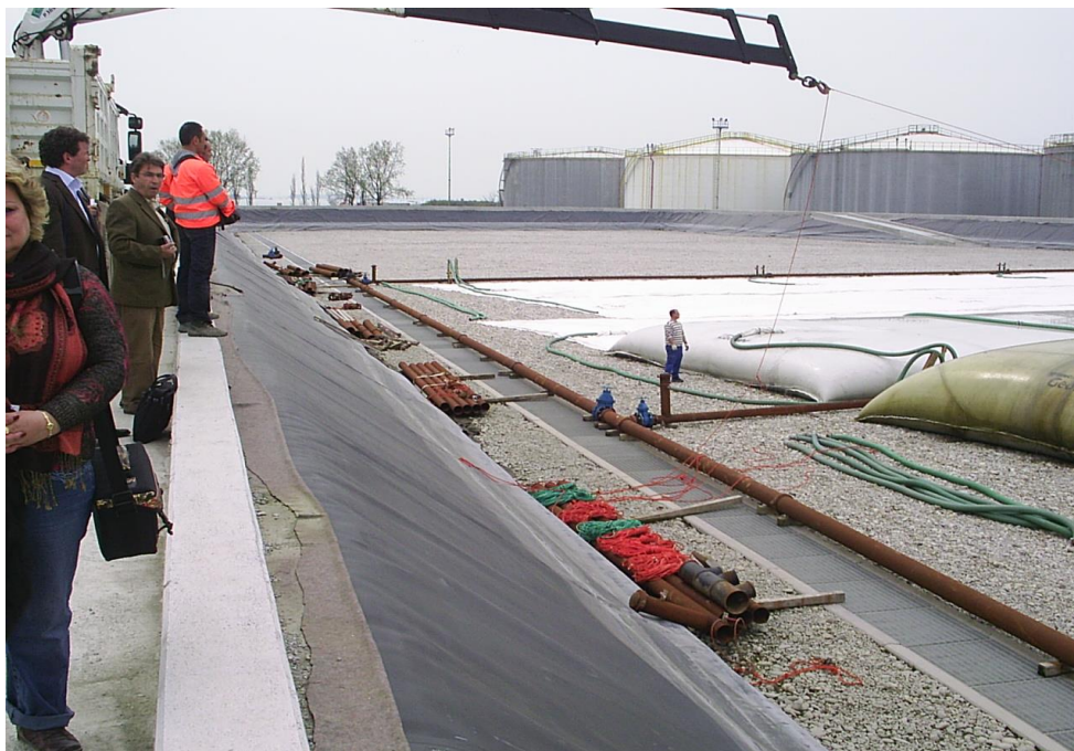
Fig. 6.11 - Depozitarea în sistem geotube Tencate
