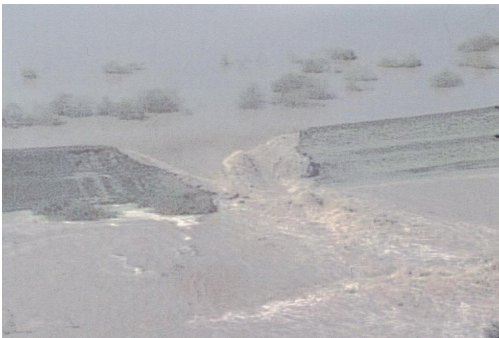
Fig. 4.47 - Ruptura de la km 6+500 pe râul Timiș la Crai Nou la viitura din aprilie 2005. Vedere din elicopter
