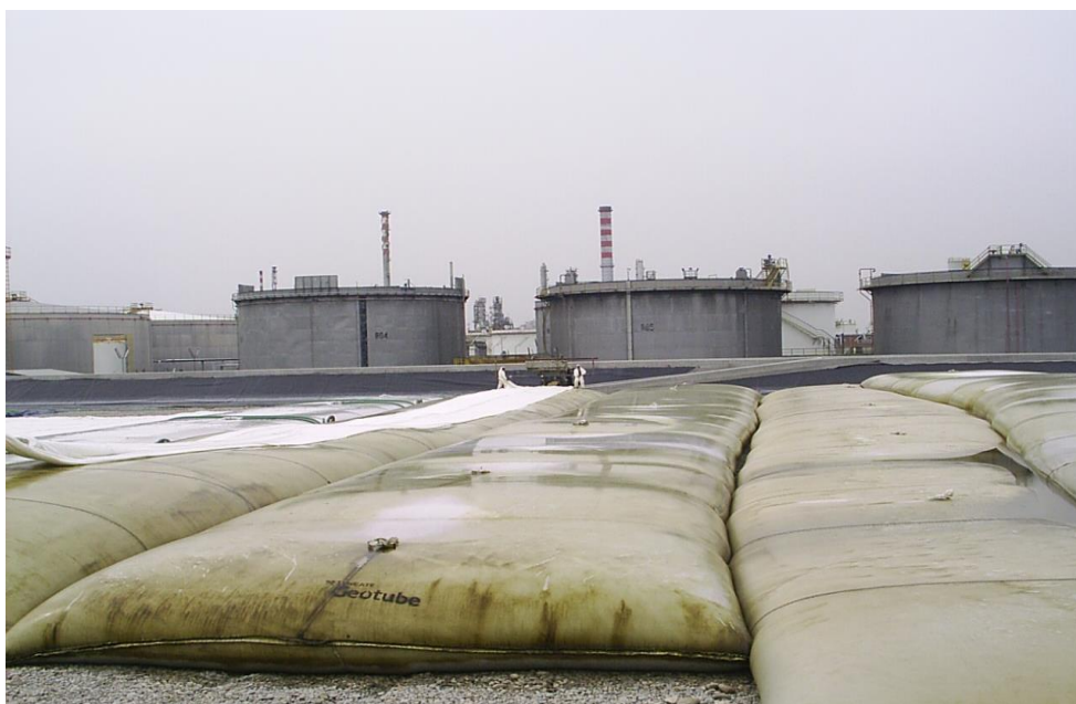
Fig. 6.12 - Depozitarea în sistem geotube Tencate
