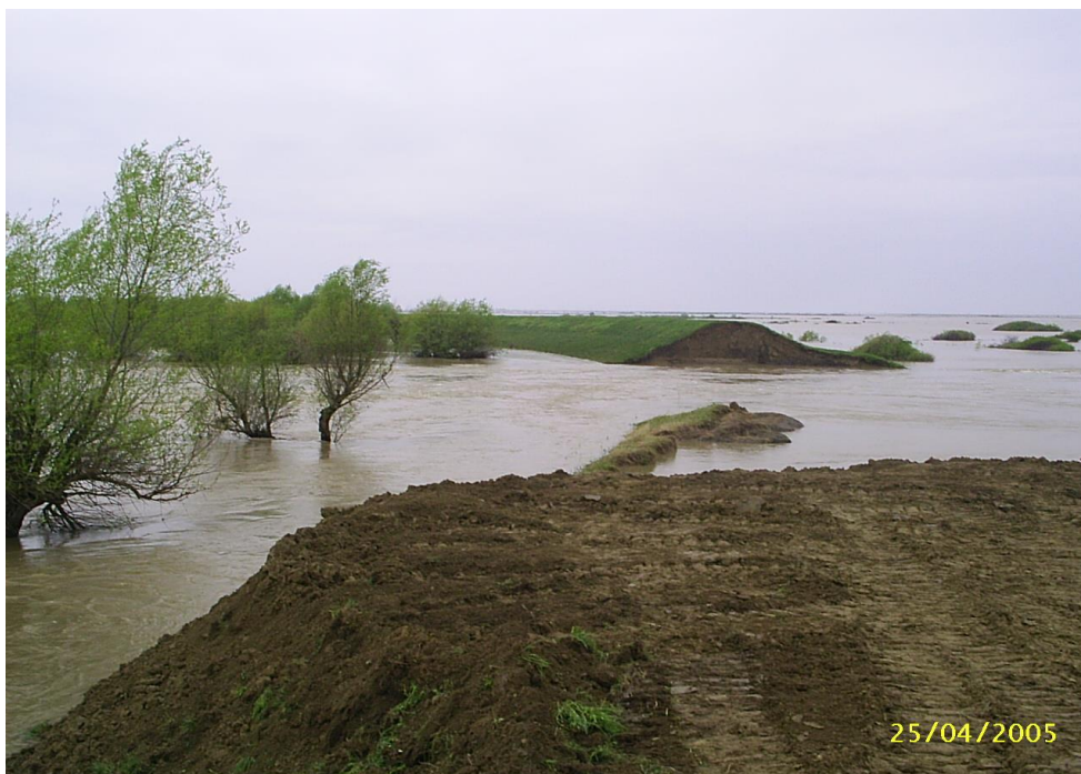
Fig. 4.51 - Ruptura în digul de la Crai Nou și vederea terenului inundat
