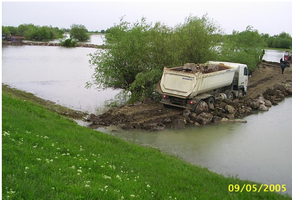
Fig. 4.57 – Finalizarea lucrărilor de închidere a breșei de la Crai Nou
