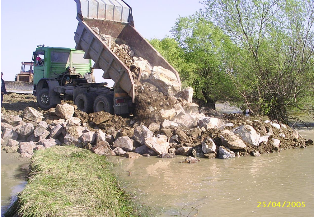
Fig. 4.52 – Începerea lucrărilor de închidere a breșei de la Crai Nou
