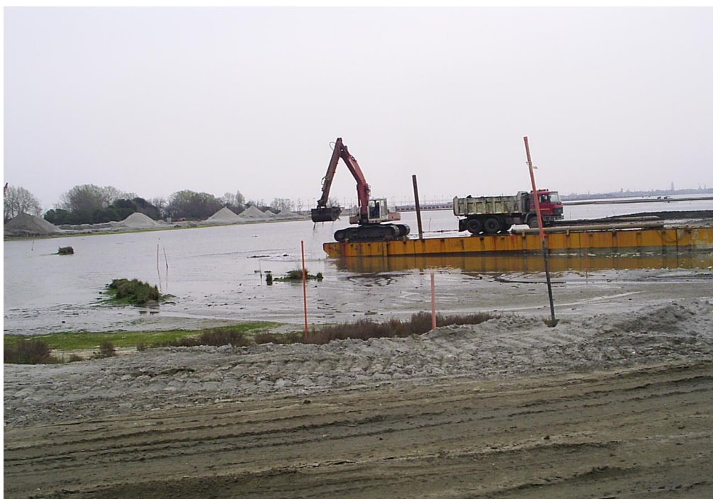
Fig. 6.9 – Decolmatare port Venetia
