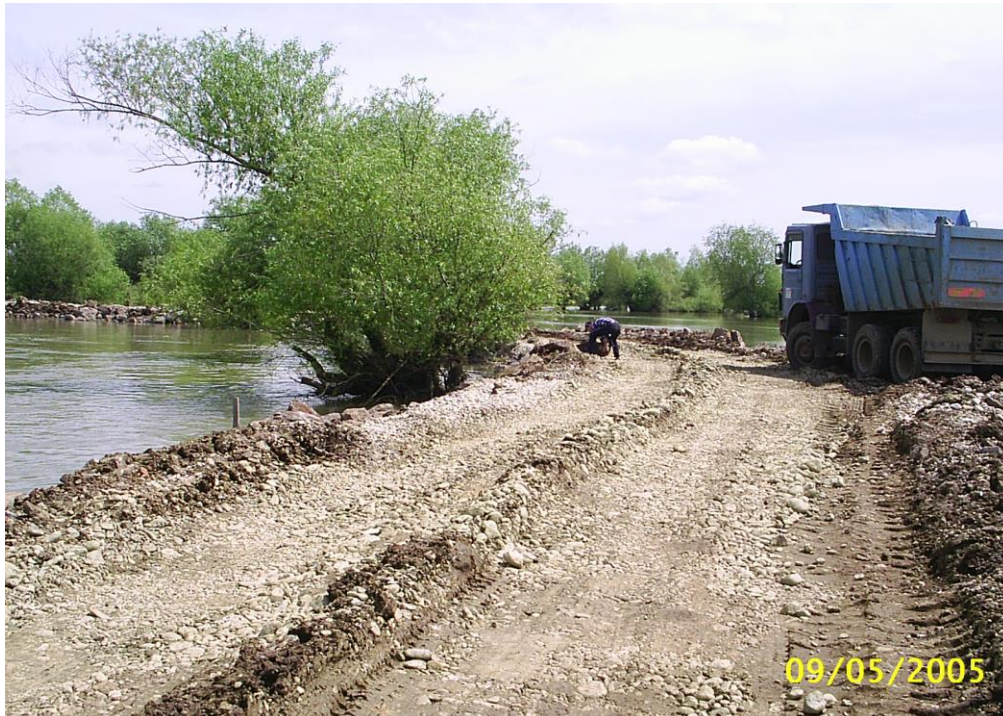
Fig. 4.54 – Lucrări de închidere a breșei de la Crai Nou
