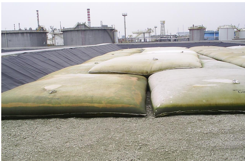
Fig. 6.10 – Depozitarea în sistem geotube Tencate
