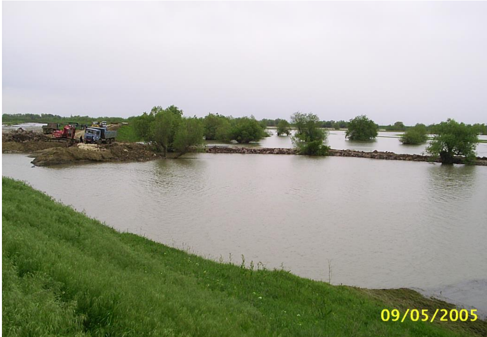
Fig. 4.56 – Finalizarea lucrărilor de închidere a breșei de la Crai Nou
