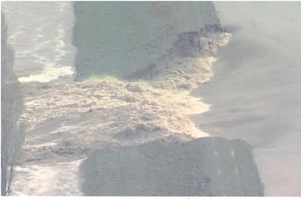
Fig. 4.49 - Ruptura de la km 6+500 pe râul Timiș la Crai Nou la viitura din aprilie 2005. Vedere din elicopter
