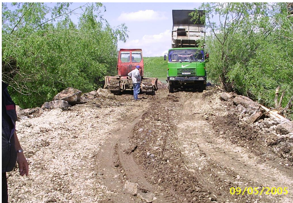
Fig. 4.55 – Lucrări de închidere a breșei de la Crai Nou
