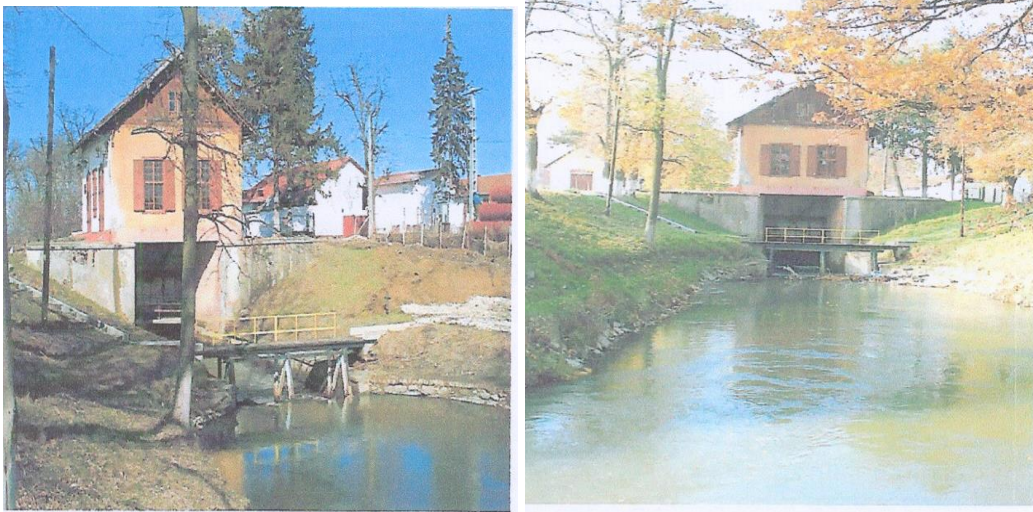
Fig. 4.2 - VEDERE A CASEI STĂVILAR DIN AMONTE
