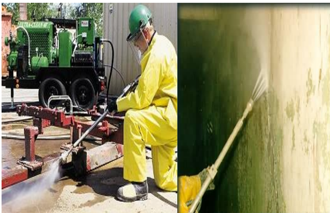
Figura 1.5.3. Curățirea cu jet de apă [ 3 ], [ 4 ]
