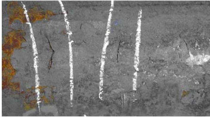
Figura 7.6. Crăpături transversale
